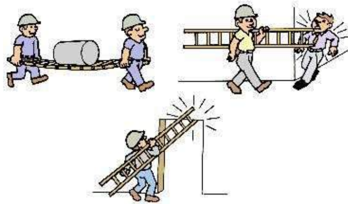
Formas incorrectas de transportar escaleras
