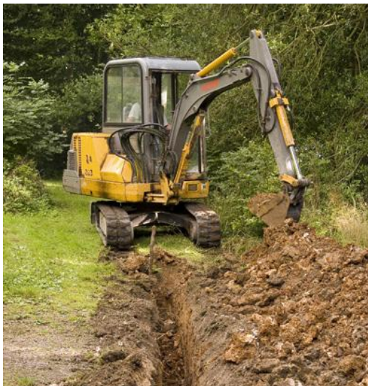
Imagen 9. Excavación de zanjas
