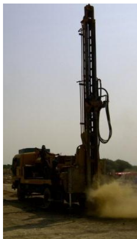
Imagen 8. Hincado de perfiles con maquinaria especializada
