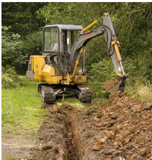
Imagen 9. Excavación de zanjas
