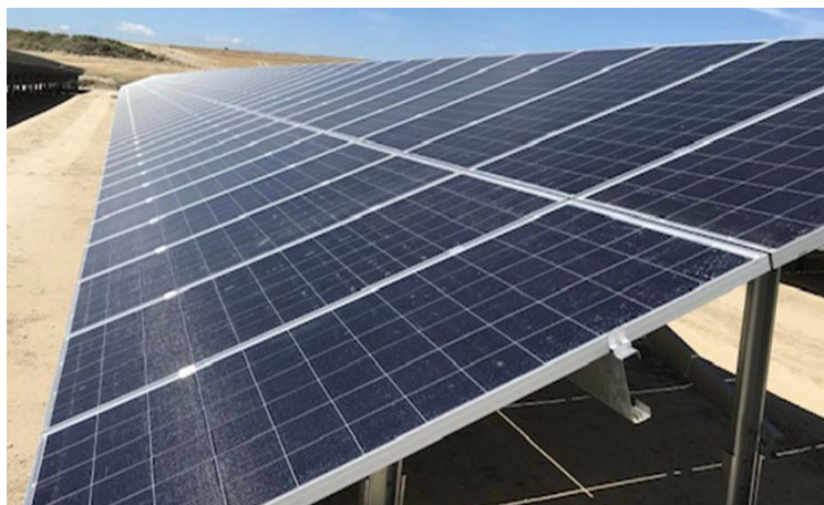
Imagen 1. Estructura 2V14
