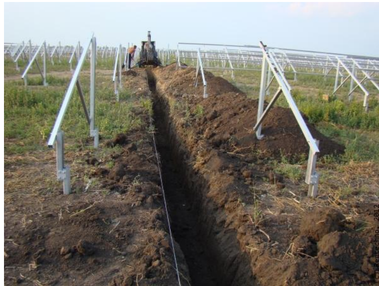
Imagen 11. Tendido de cable en zanja
