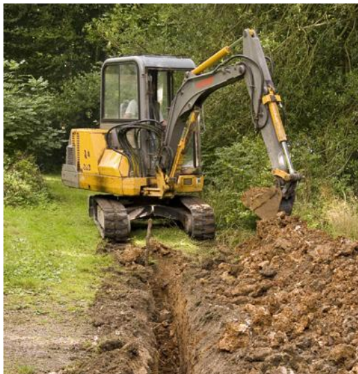
Imagen 9. Excavación de zanjas
