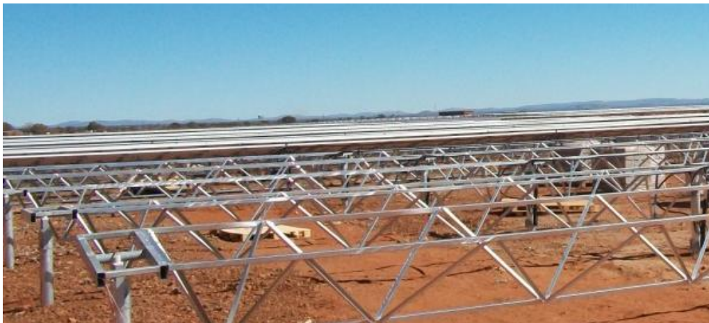
Imagen 10. Montaje de estructura solar con perfiles hincados directamente en el terreno
