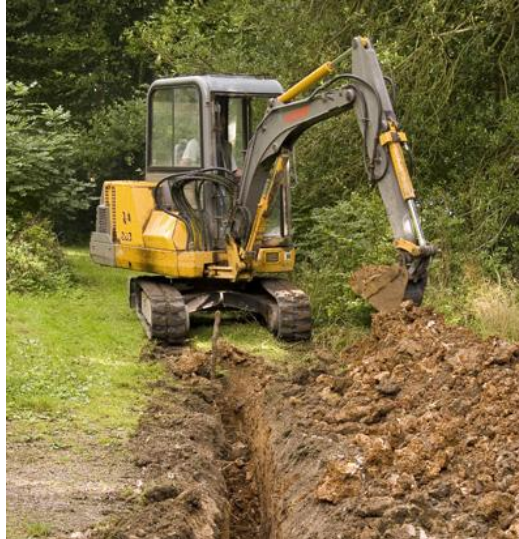
Imagen 9. Excavación de zanjas
