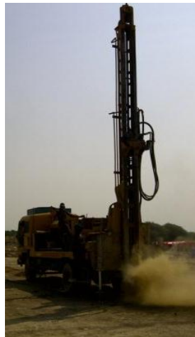
Imagen 8. Hincado de perfiles con maquinaria especializada
