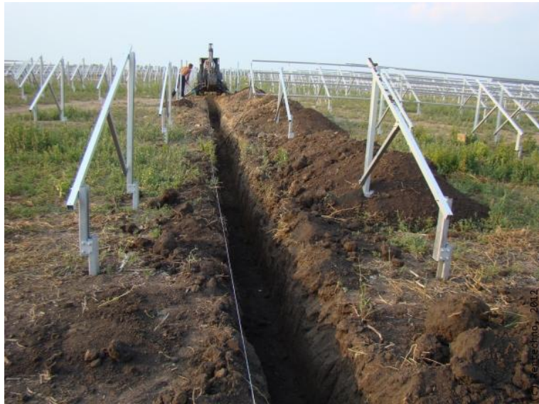
Imagen 11. Tendido de cable en zanja
