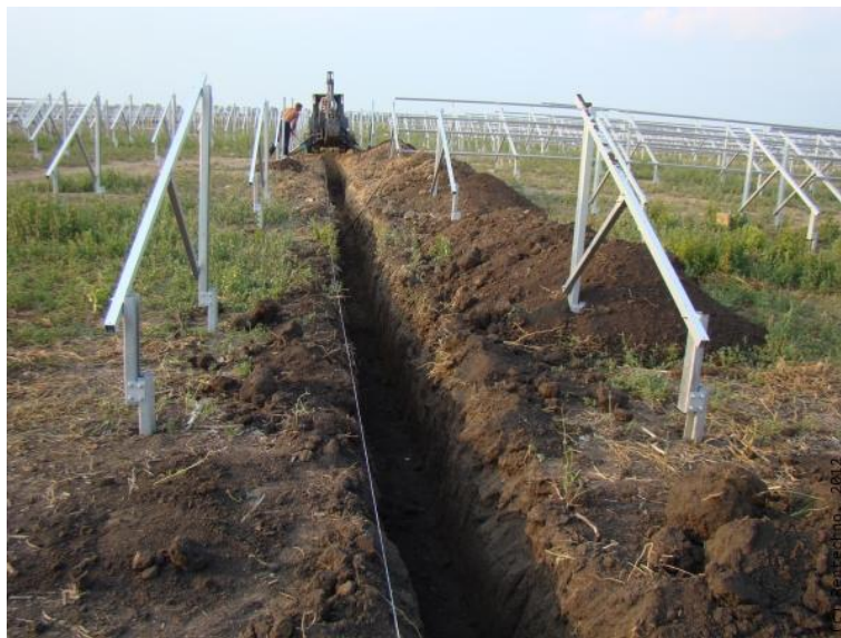
Imagen 11. Tendido de cable en zanja
