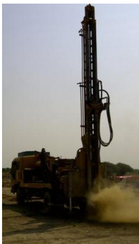
Imagen 8. Hincado de perfiles con maquinaria especializada
