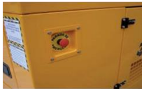
Dispositivo de parada de emergencia
