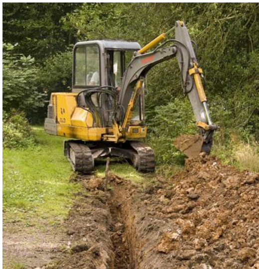
Imagen 9. Excavación de zanjas
