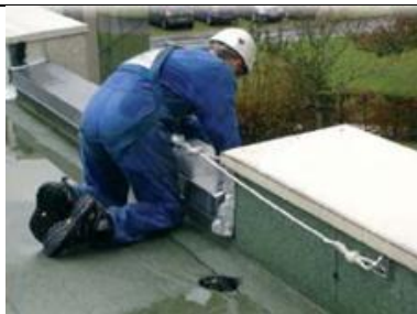
Clase A1: Anclajes estructurales sobre superficies verticales, horizontales e inclinadas
