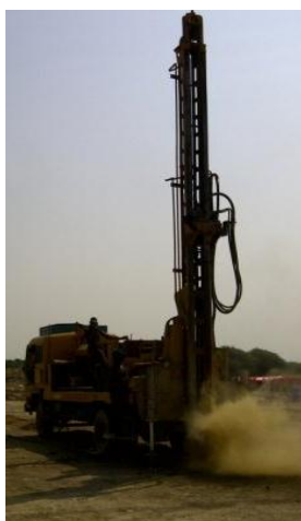
Imagen 14. Hincado de perfiles con maquinaria especializada
