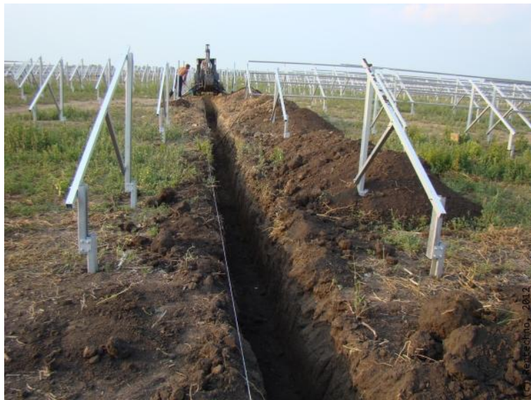
Imagen 17. Tendido de cable en zanja
