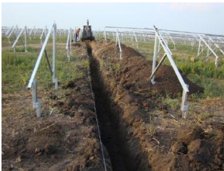
Imagen 28: Tendido de cable en zanja.
