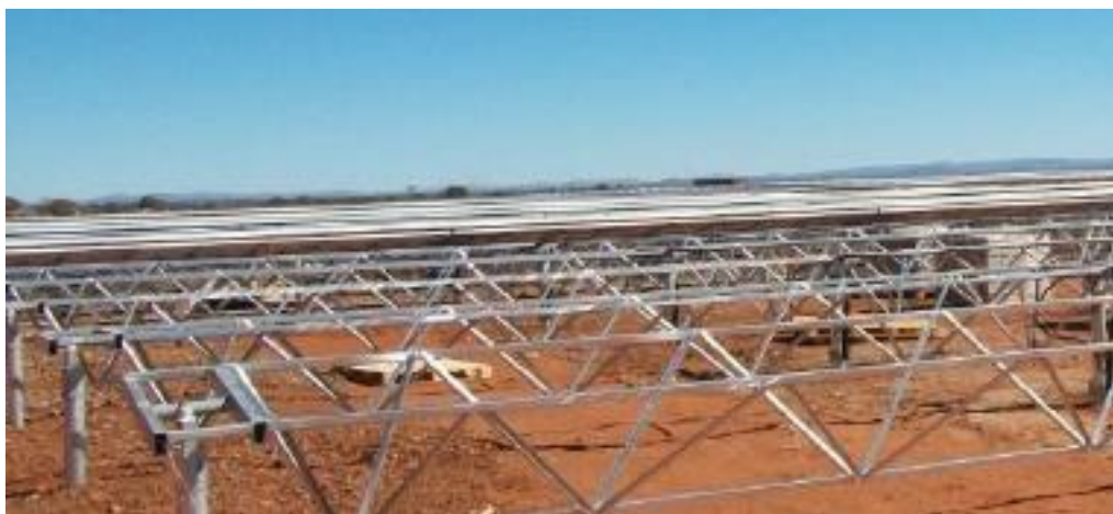
Imagen 27: Montaje de estructura solar con perfiles hincados directamente.
