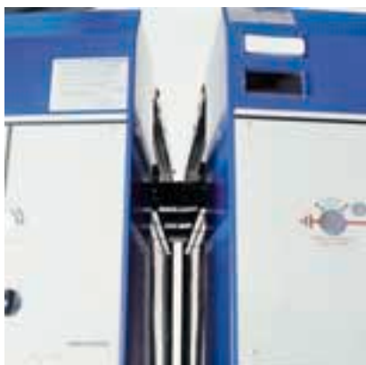
Detalle de conexión entre una CGC y una CMP-F
