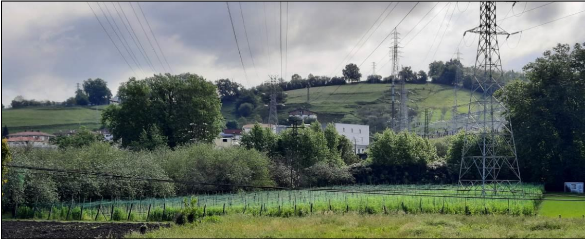
Fotografía 7. Vista del apoyo 20059 (derecha) y entorno del apoyo proyectado 10002N (centro) de la línea Hernani-Azpeitia. Tras la campa, vegetación de ribera a podar.
