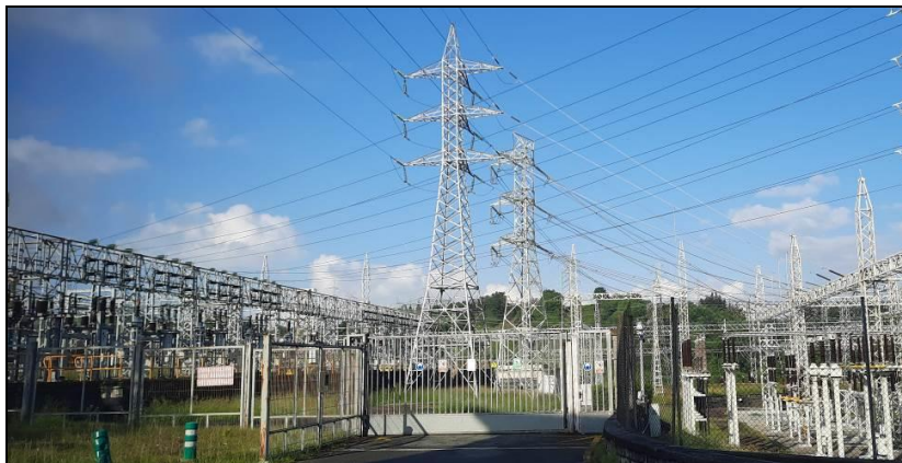
Fotografía 18. Vista del apoyo 10001 de la línea Hernani-Oiartzun a desmontar, en el interior de la subestación.
