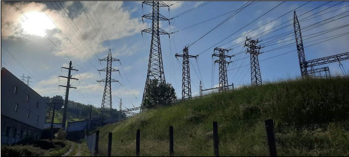
Fotografía 16. Vista de los apoyos 20060 (izq.) y 10002 (der.), ambos a desmontar.
