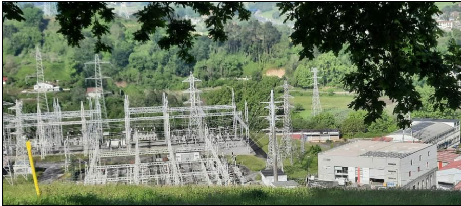
Fotografía 18. Vista general de la subestación ST Hernani. Las líneas y apoyos a desmontar se encuentran entre la subestación y el polígono.
