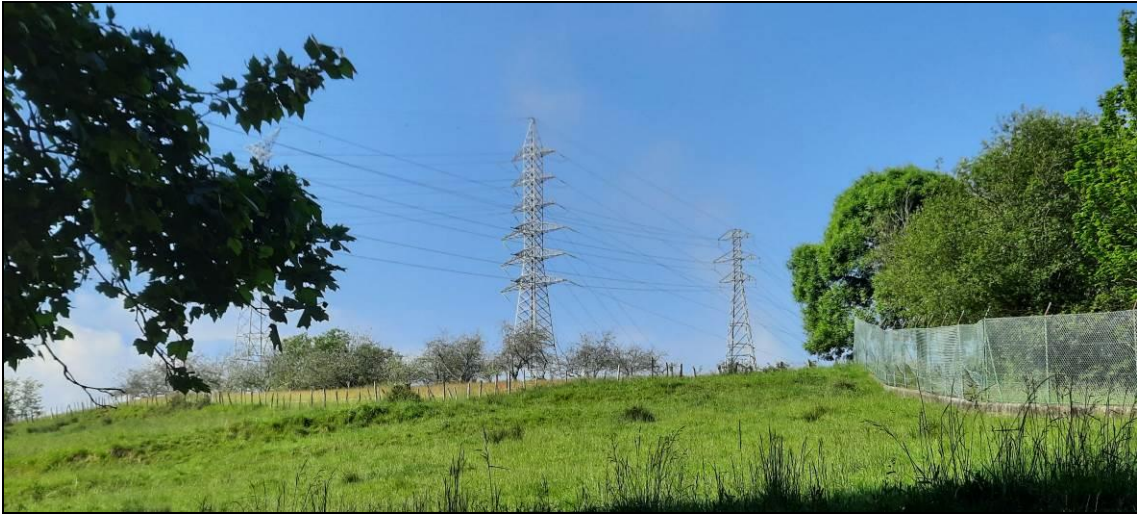
Fotografía 21. Vista desde el este del ámbito de estudio. En el centro, apoyo 10003 de la línea Hernani-Oiartzun, y a su derecha, apoyo 10002 del tramo de la misma línea a mantener.
