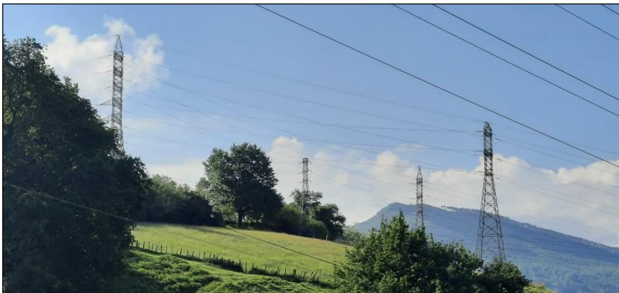
Fotografía 19. Vista del apoyo 10003 desde donde salen las 2 líneas Hernani Oiartzun hacia la ST Hernani (izquierda) y de los 2 apoyos 10002 de las mismas líneas (derecha). Se mantendrá el apoyo más a la derecha en la imagen.
