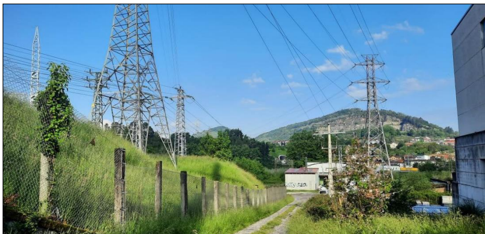
Fotografía 15. Vista de los apoyos 20060 (izq.) y 10002 (der.), ambos a desmontar.
