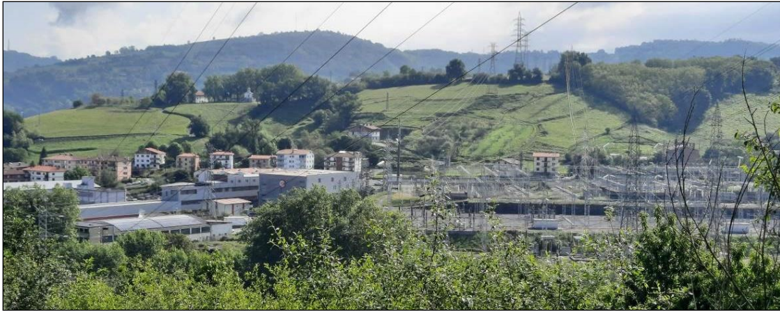
Fotografía 1. Vista panorámica desde el apoyo 10003 de la línea Hernani-Azpeitia hacia el este del ámbito de estudio. Al fondo, tras la ST Hernani, apoyos 10002 y 10003 de la línea Hernani-Oiartzun.
