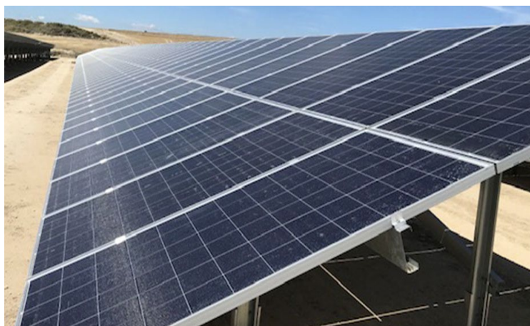
Imagen 1. Estructura 2V14
