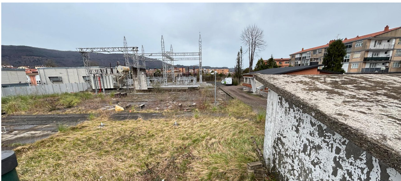
Fotografía 2. Detalle fotográfico de la ST IRUN 30 KV enlazada con la planta BESS proyectada.
