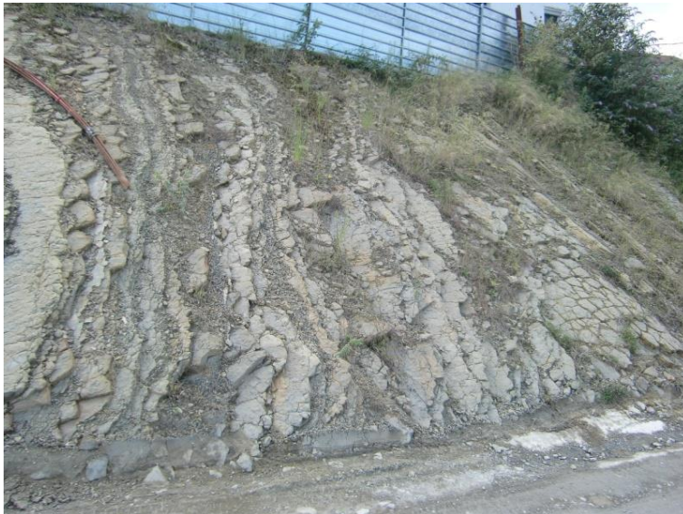
Fotografía n°3. Detalle flysch (litotipo FDC). Alternancia de margas y bancos cm de calcarenitas. (GM III-IV).
