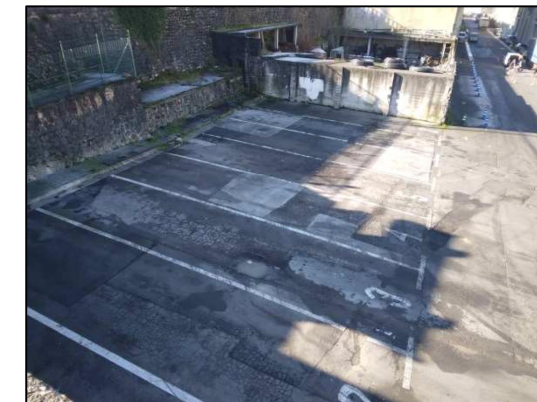
Fotografía oblicua tomada desde la pasarela anexa. Se observan las líneas pintadas en el suelo para el aparcamiento de camiones.
