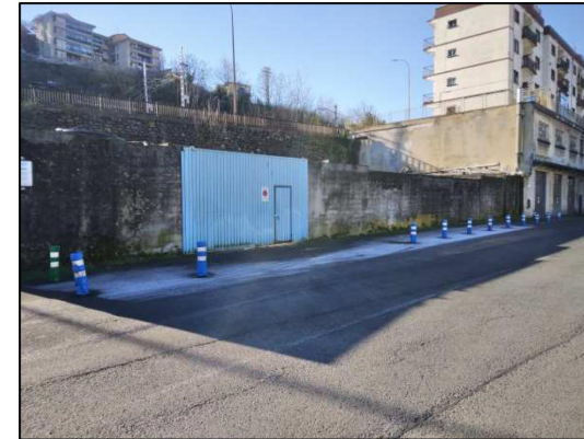
Vista general desde del exterior
