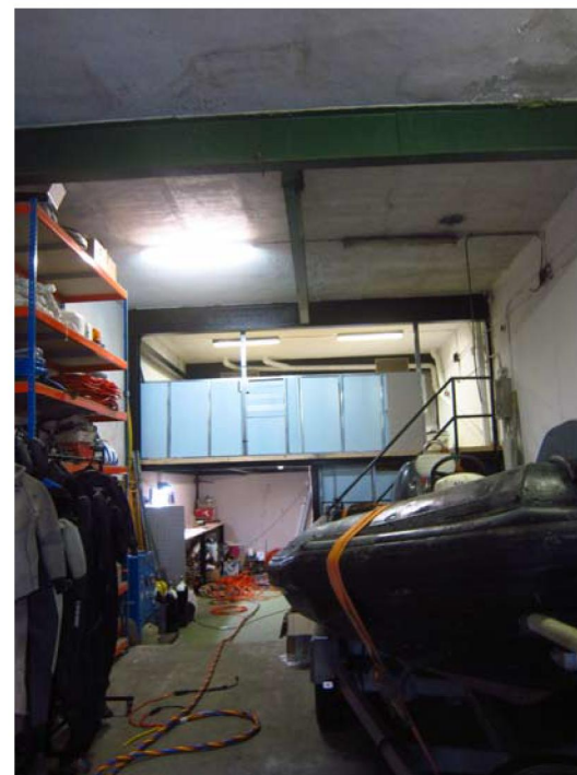
F4: Interior del edificio 9H
