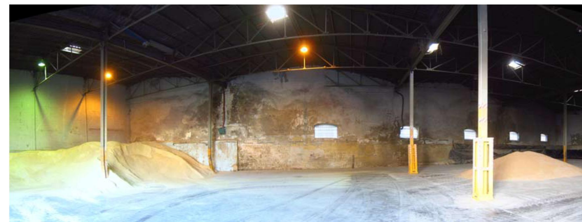
F15: Interior del edificio 6H.
