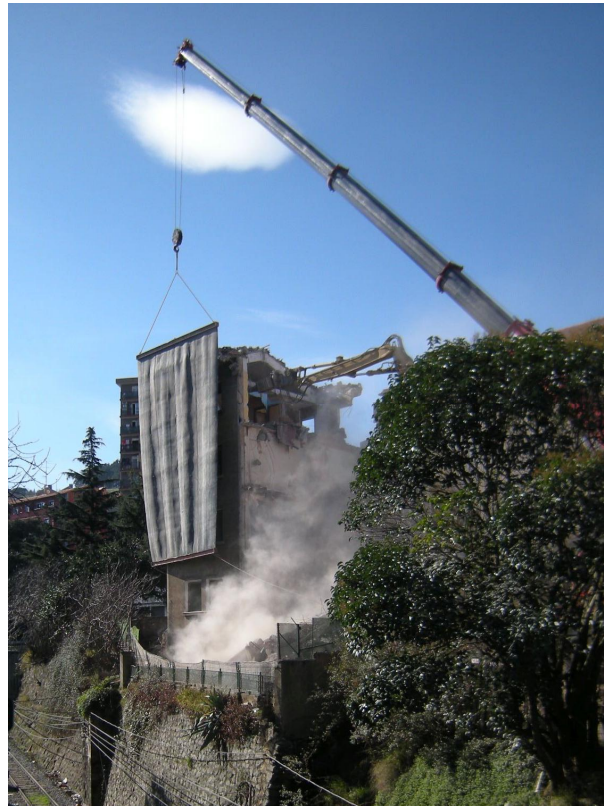
Empleo de una pantalla para evitar la proyección de escombros
