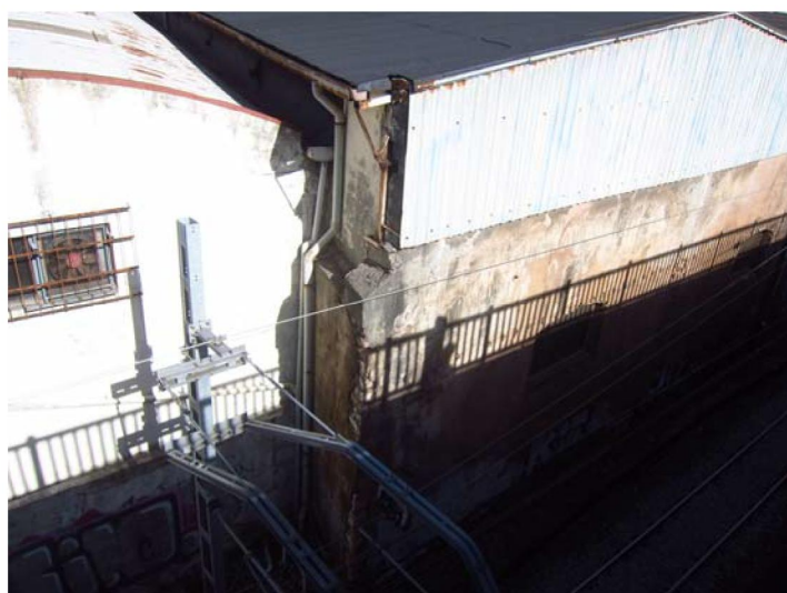
F12: Fachada sur. Medianera entre los edificios 5H y 6H
