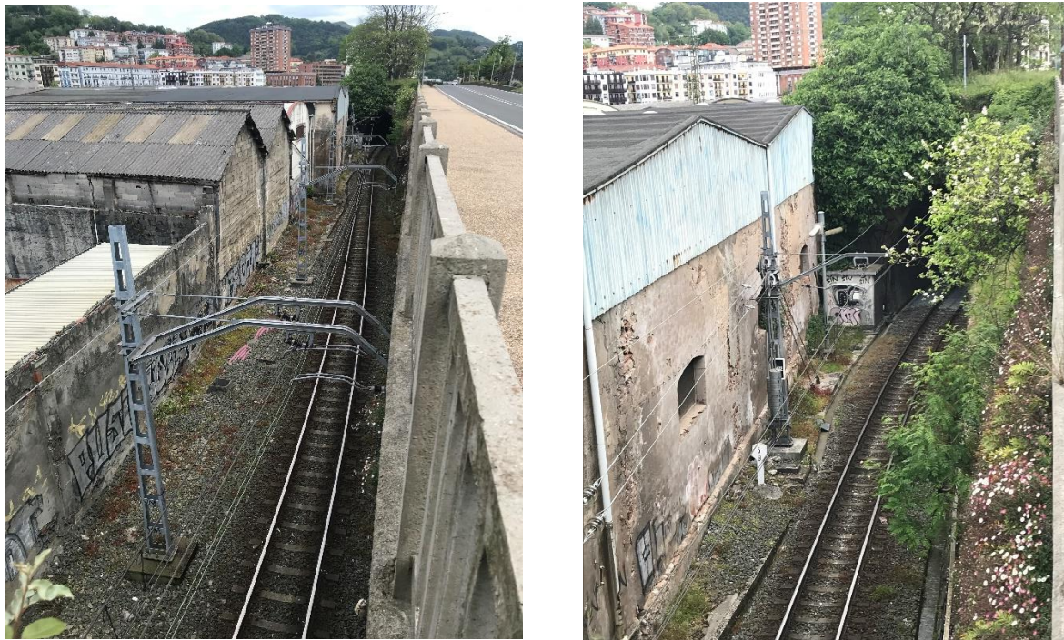
FIGURA 6. INSTALACIONES EXISTENTES EN ZONA DE CONEXION
