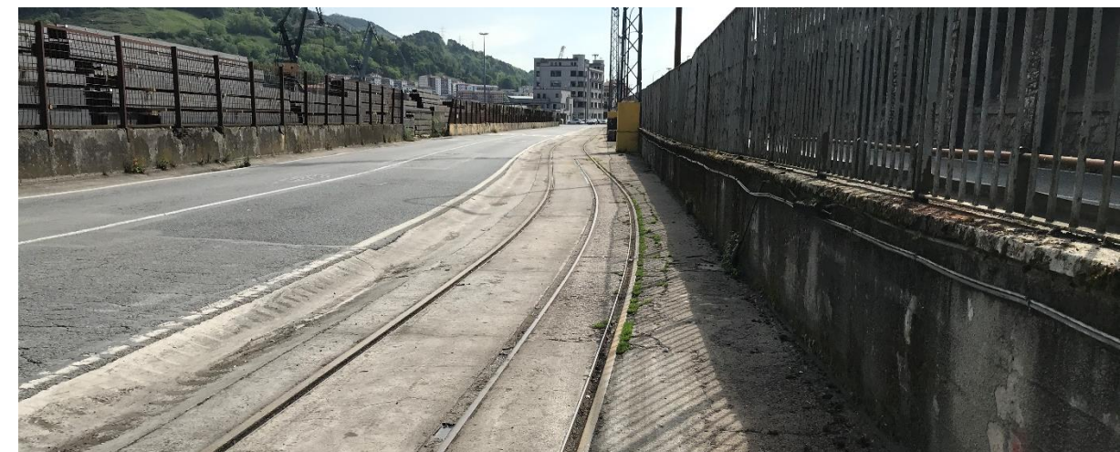
FIGURA 8. TRAZADO EN CURVA Y CONTRACURVA CON GÁLBO LATERAL INSUFICIENTE
