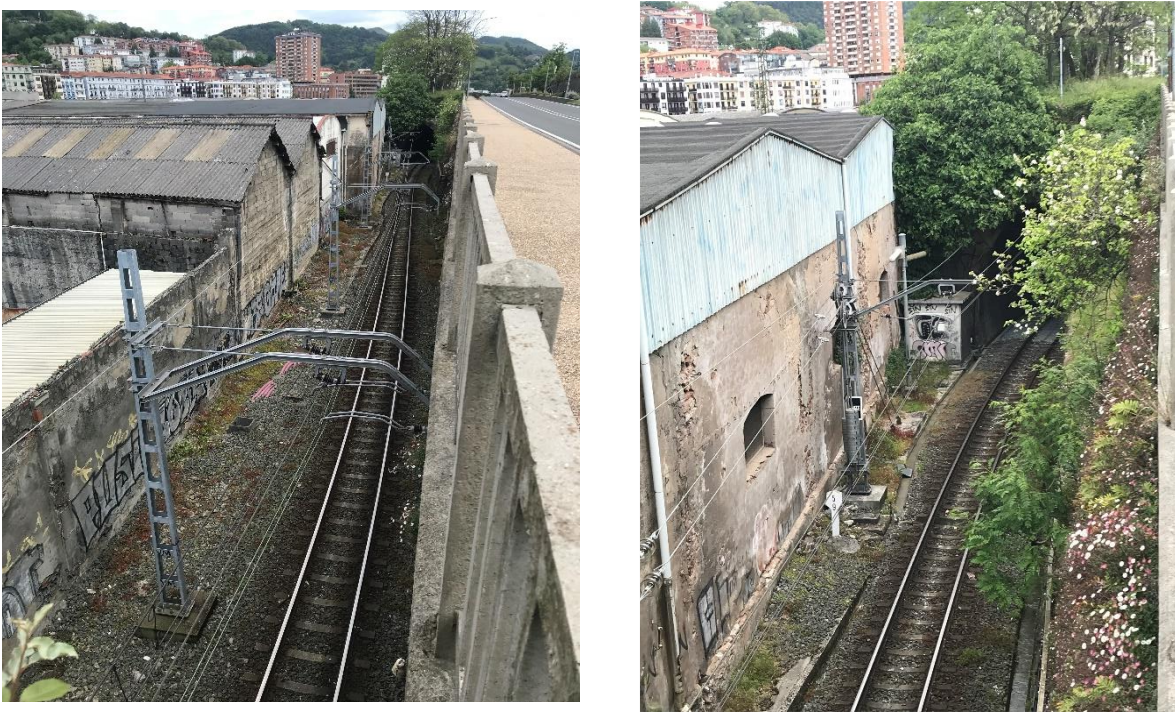
FIGURA 5. INSTALACIONES EXISTENTES EN ZONA DE CONEXION
