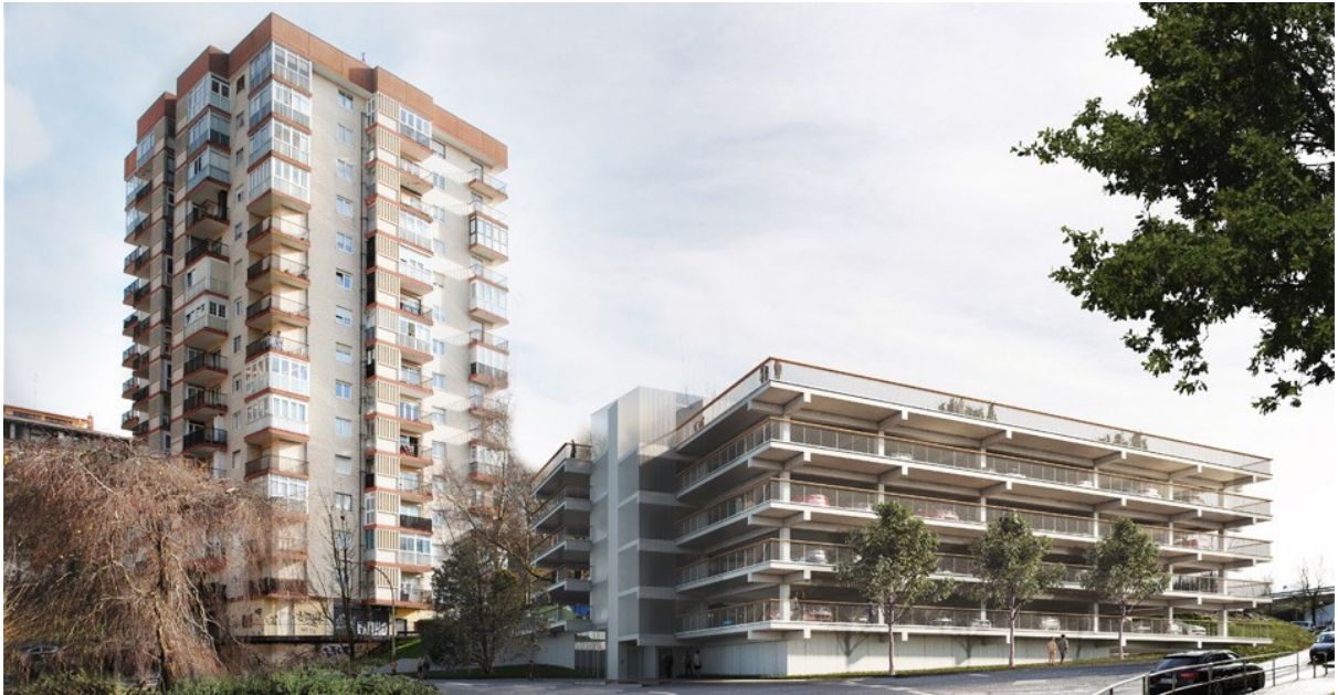
Aurrefabrikatutako aparkaleku eraikina, Altza auzoan. Vaumm-en proposamena.
