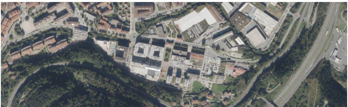
Reforma del Área Industrial de Serrería y Txeta en Arrasate. Sustitución total de actividades sin conservación.
