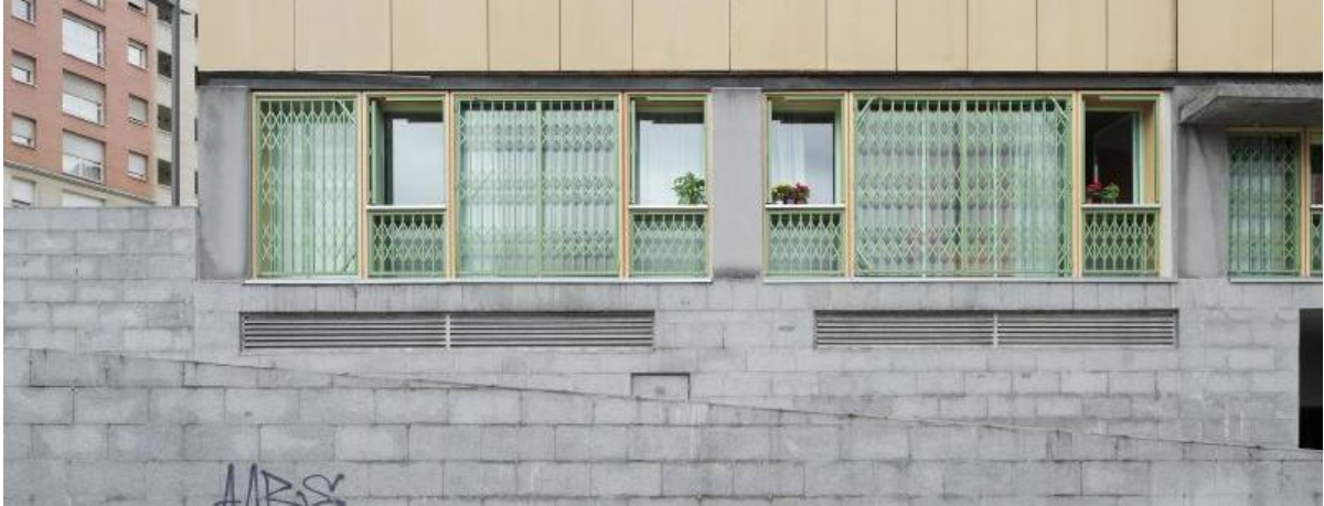
Proyecto Loft Studio House realizado por el estudio AZAB en el barrio bilbaíno de La Mina.
