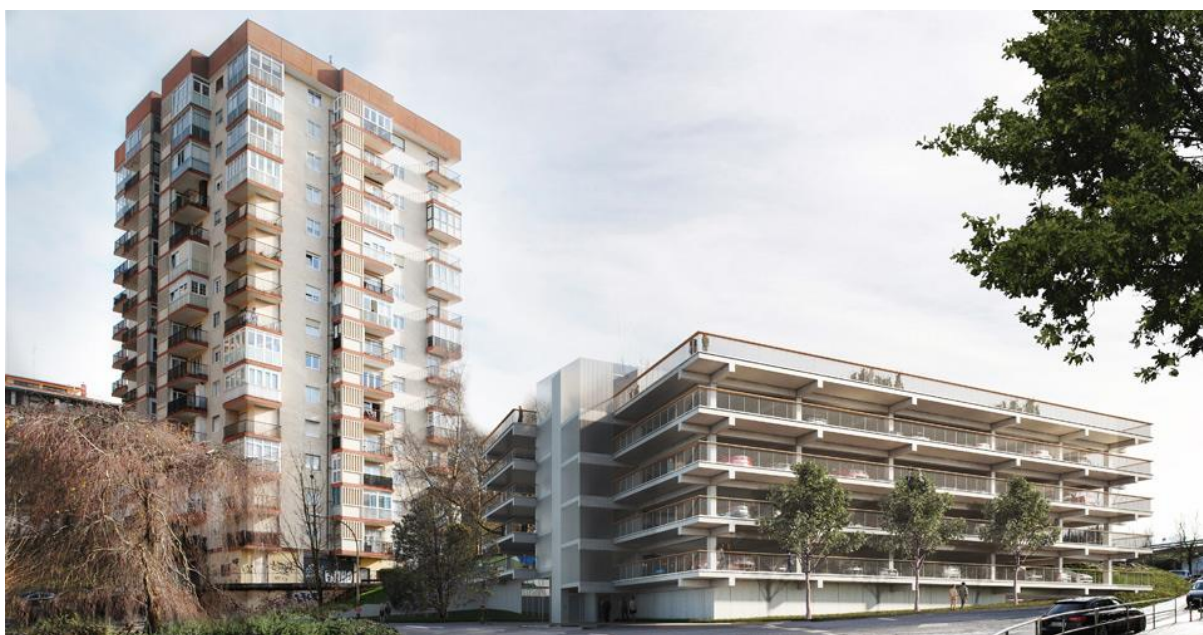
Edificio de aparcamiento prefabricado en el barrio de Altza. Propuesta de Vaumm.
