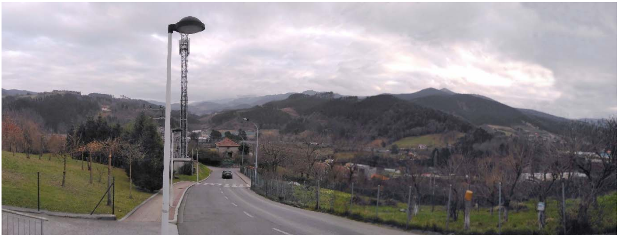
Foto 2. Estado tras el desmontaje de la línea actual desde el entorno de Bakiola, en Ugao-Miraballes
