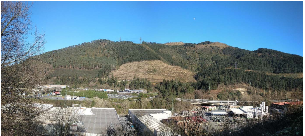
Foto 5. Situación tras las obras en el entorno de la estación de servicio de Arrigorriaga.
