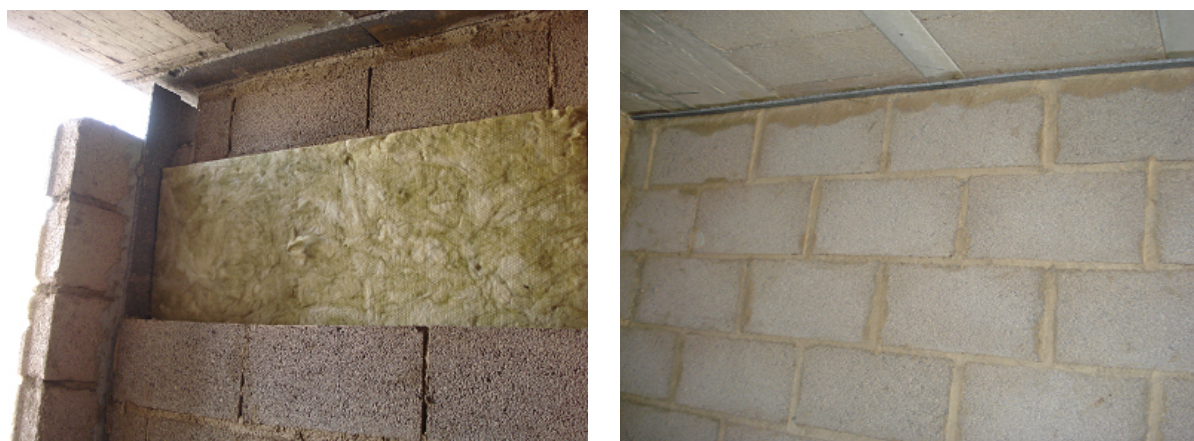
Figura 9. Ejecución en obra de pared doble desconectada.
