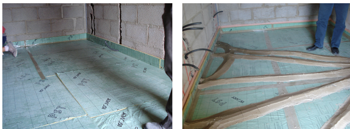
Figura 10. Colocación en obra de elemento anti-impacto sobre forjado.
