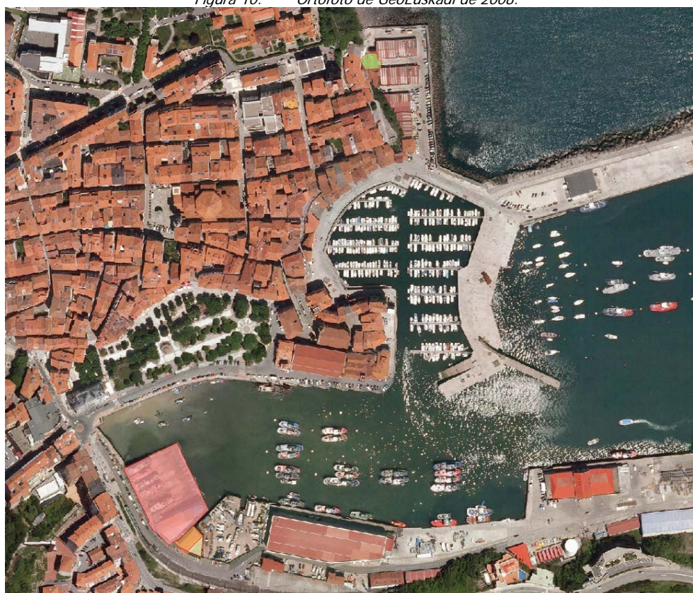
Figura 11. Ortofoto de GeoEuskadi de 2009.
