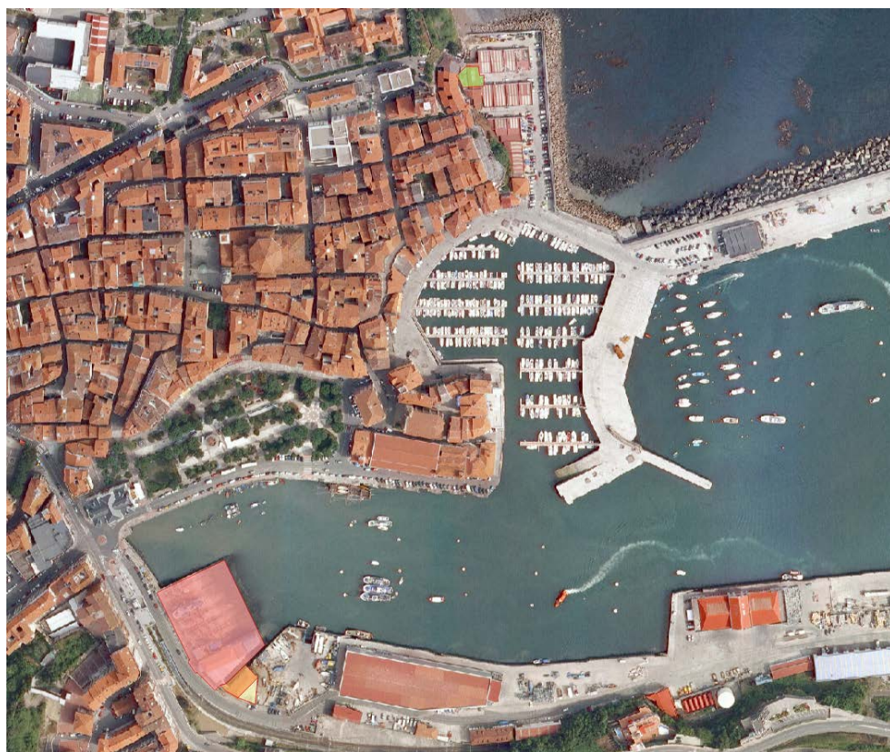
Figura 10. Ortofoto de GeoEuskadi de 2008.
