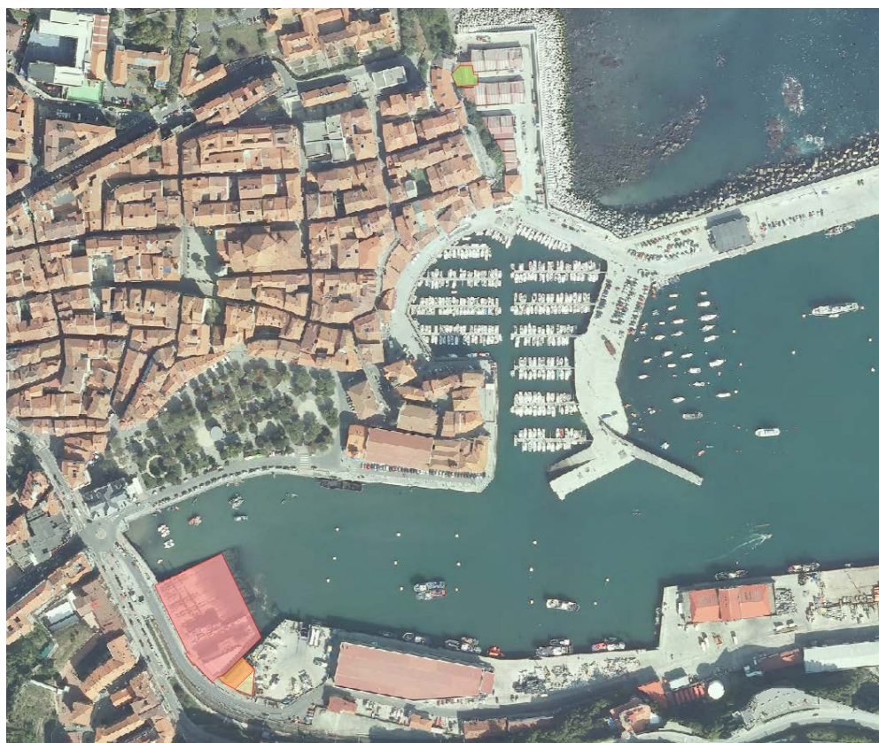
Figura 16. Ortofoto de GeoEuskadi de 2014.
