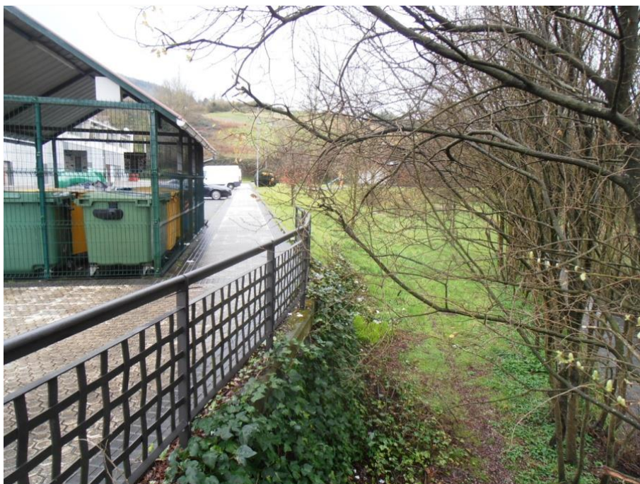
Recrecido de murete y sustitución de barandilla aguas arriba del puente de Oialume en la margen derecha.
