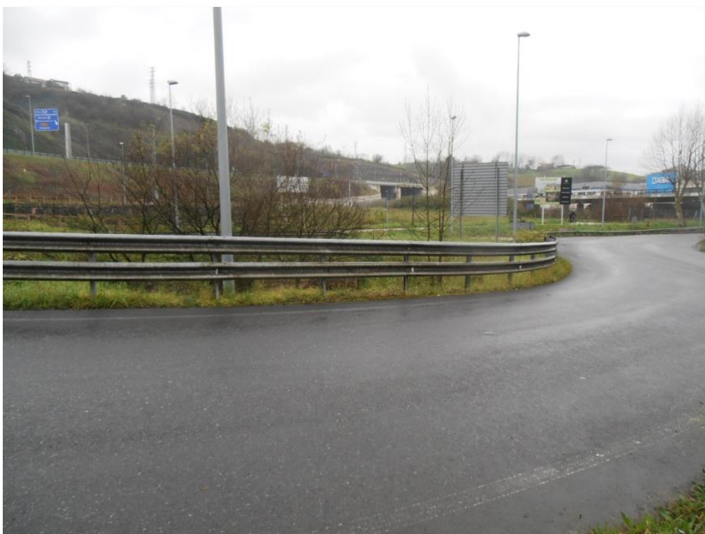
Murete entre el viaducto del Tren de Alta Velocidad y la regata Akan (arriba) y sustitución de la doble bionda por New Jersey estanca de hormigón armado.
