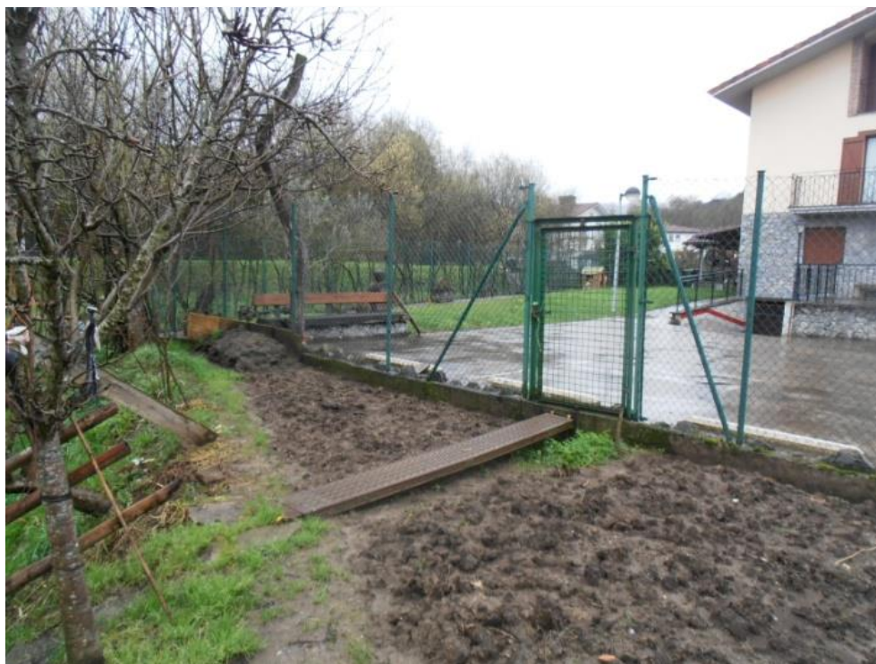
Recrecido del muro perimetral del cierre y sustitución del vallado.
