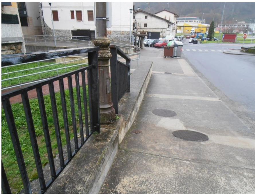
Recrecido parcial de los dos muretes sobre el que se apoya la barandilla en la margen derecha del puente de Ergobia.
