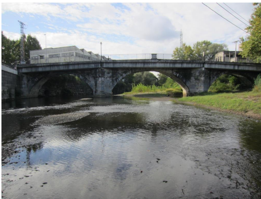
Río Urumea discurriendo por un ojo del puente. Se prevé liberar el central de acarreo y al ojo de la margen izquierda dotarle de un cauce para aguas altas.
