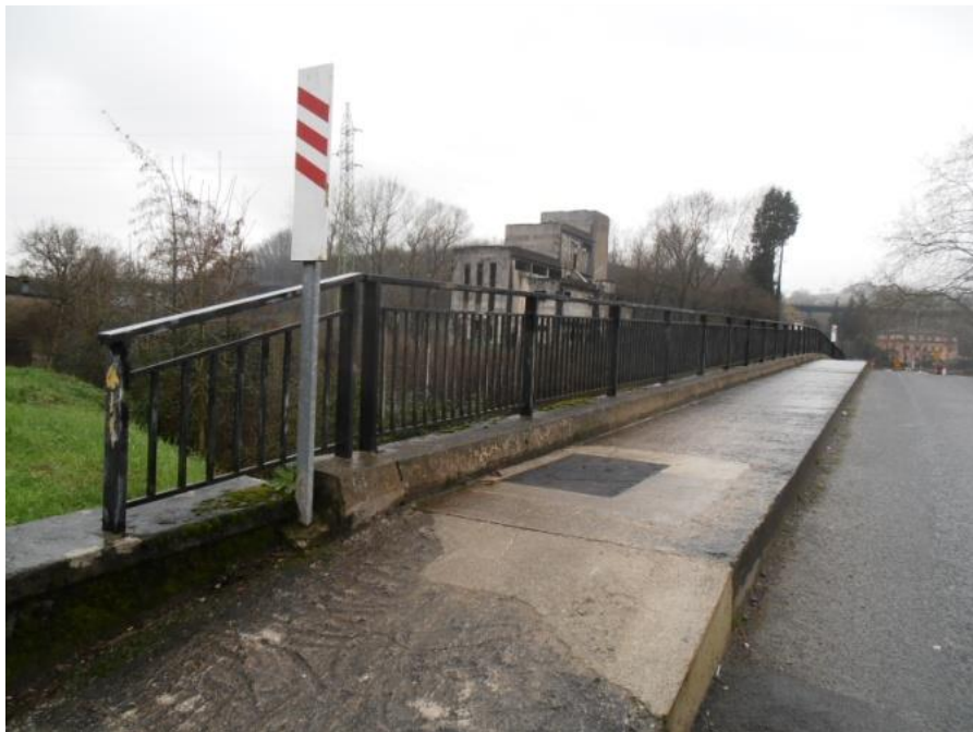
Recrecido parcial de los dos muretes sobre el que se apoya la barandilla en la margen derecha del puente de Ergobia.
