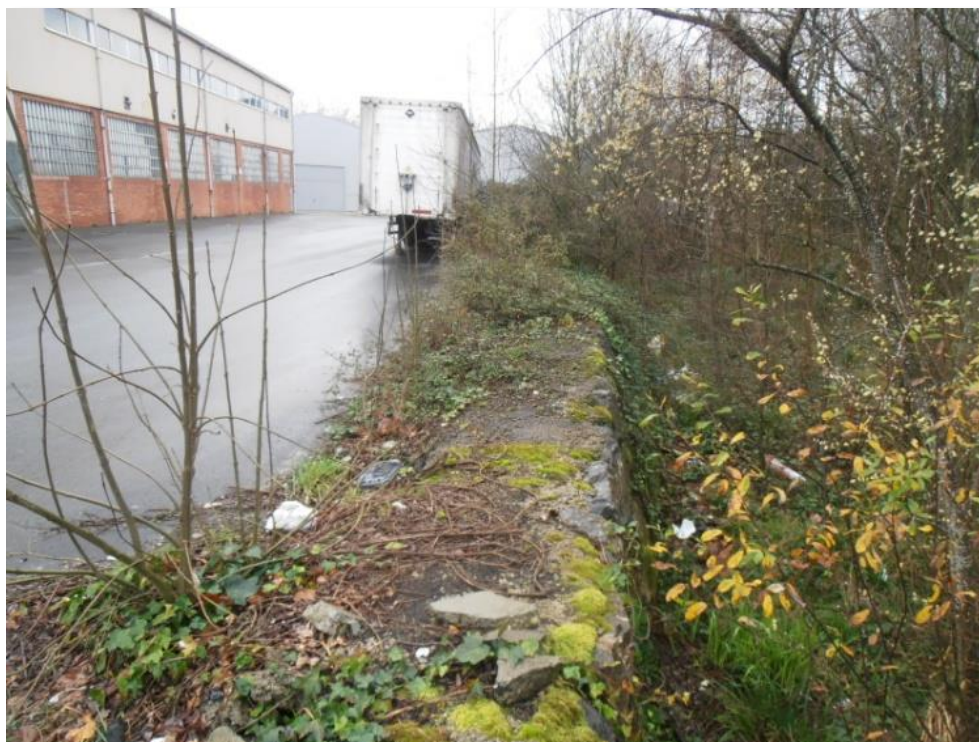
Murete sobre muro de escollera en la margen izquierda de la regata Oialume y lezón (en la foto inferior).
