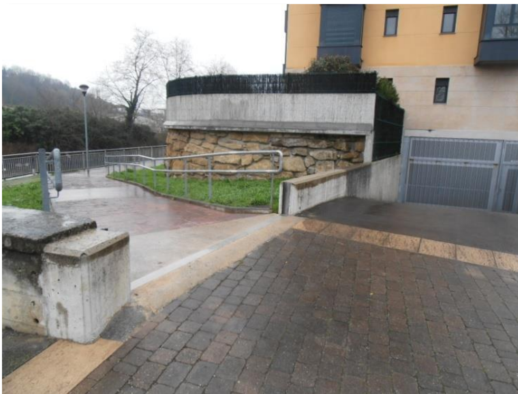
Recrecido del muro de acceso al paseo de ribera (arriba) y ejecución de muro en el aparcamiento junto al bordillo hasta la fachada del pabellón.
