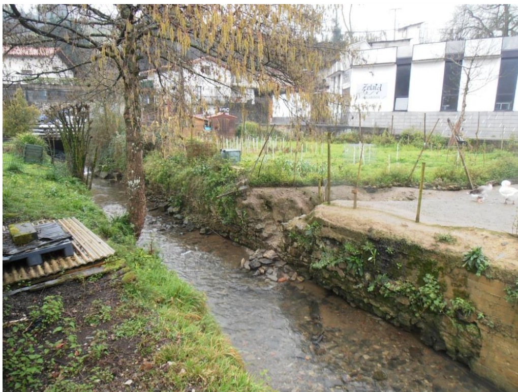
Murete sobre muro de encauzamiento en la margen izquierda de la regata Oialume
