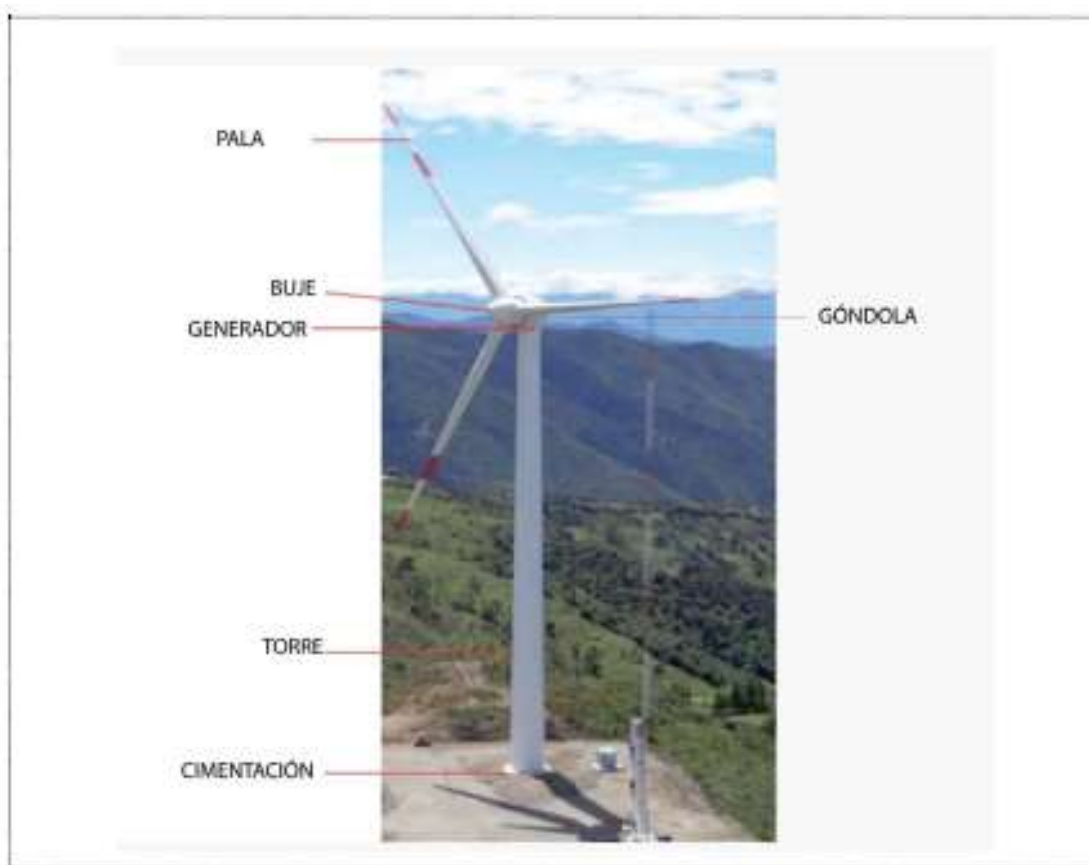
Figura XXVIII-12: Diagrama ilustrativo de os elementos de un aerogenerador.
