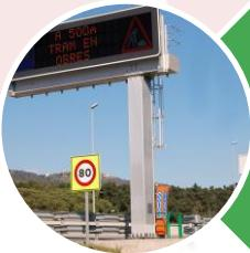
Mejorar la información al conductor usuario de la vía mediante paneles de señalización variable, fijos y móviles.
