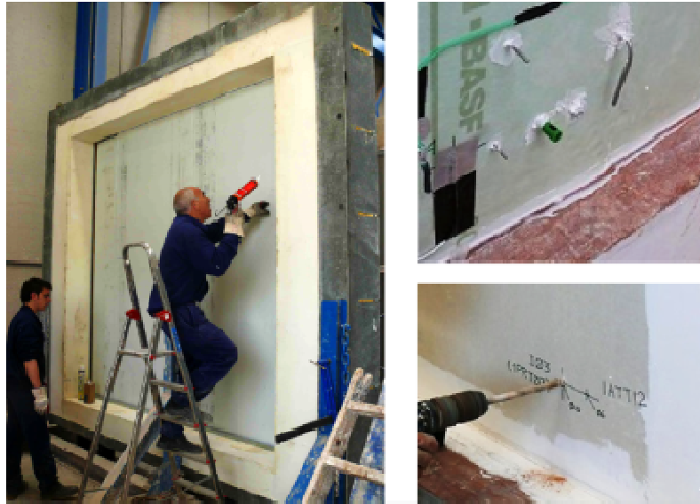
Figura 8 - Construcción de la muestra
