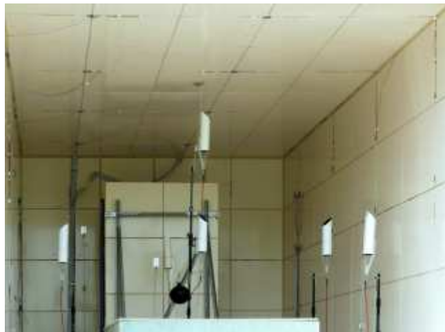
Figura 2: Instalación de las HFS Tiles.
