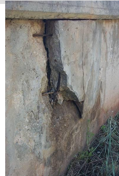
Rotura por punzonamiento
