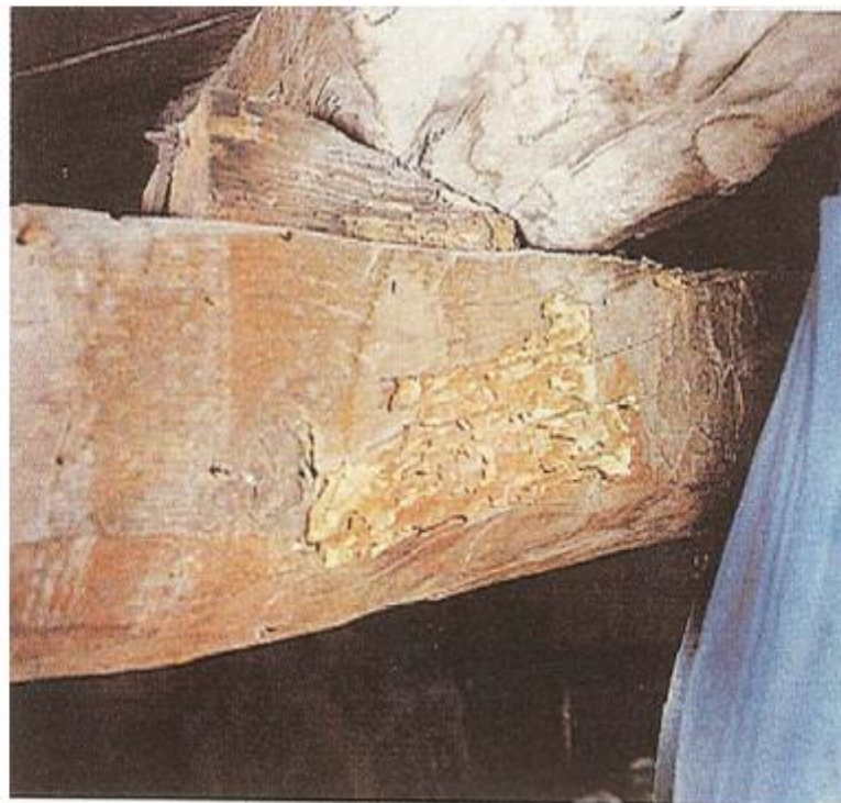
Ataque de Carcoma a una viga
