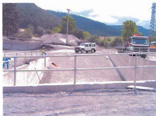
Imagen en detalle de la balsa reformada
