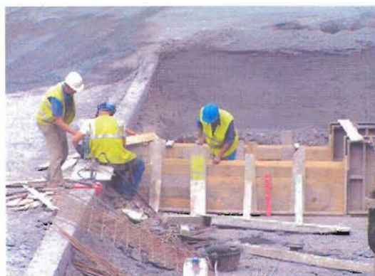
Reforma de la balsa de decantación del pozo tunel, para separar las aguas que proceden del pozo de las provenientes de las escorrentías de las pistas
