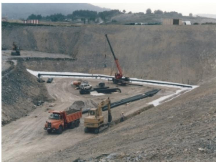
Foto 6.3.: Instalación del sistema de recogida de lixiviados
