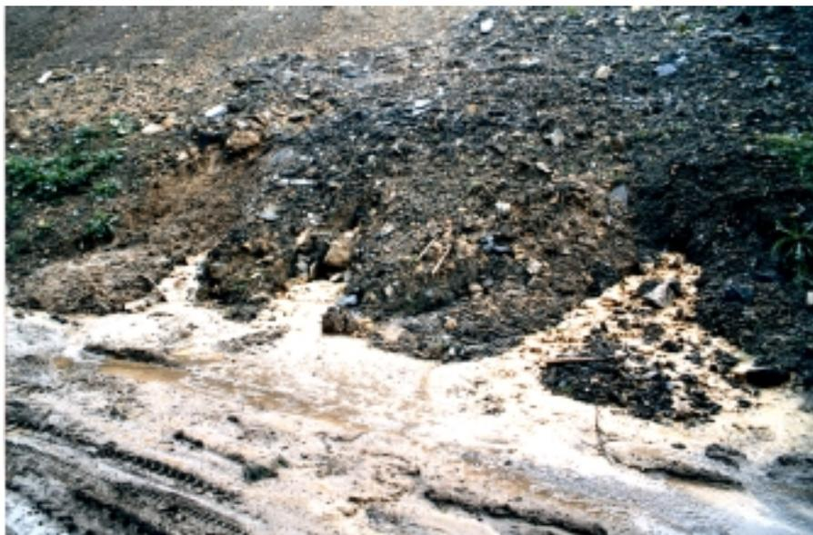
**Foto 3.1.: Surgencia de lixiviados al pie del talud del vertedero.**
