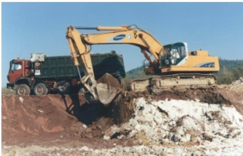
**Foto 6.4.: Excavación y retirada de los residuos de un vertedero.**
