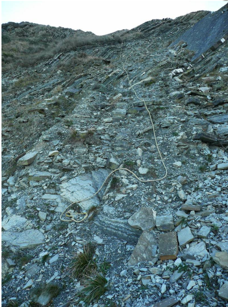
Figura 40. Acceso abrupto que dificulta el acceso a determinadas zonas.
