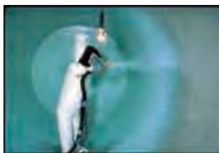
Figura 35: Imprimación interna de un tanque
