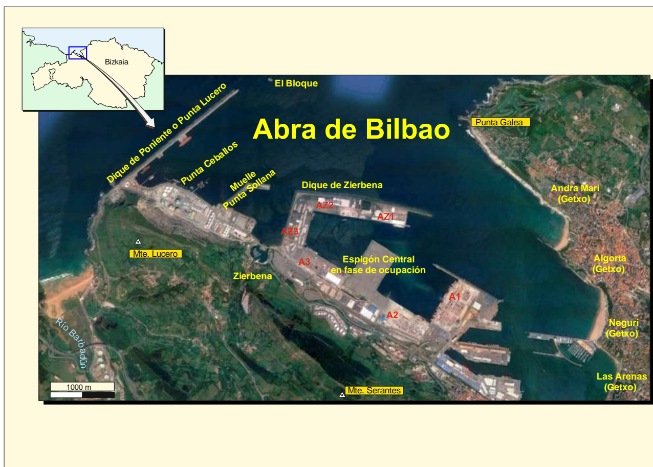
Figura 1. Localización del Puerto de Bilbao, donde se aprecia la ubicación del dique de Poniente o Punta Lucero.
