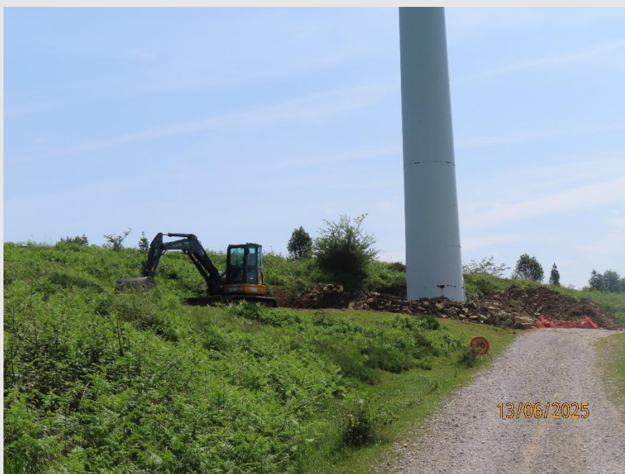
Fotografía 2. Trabajos de movimientos de tierras en la base de los aerogeneradores.
