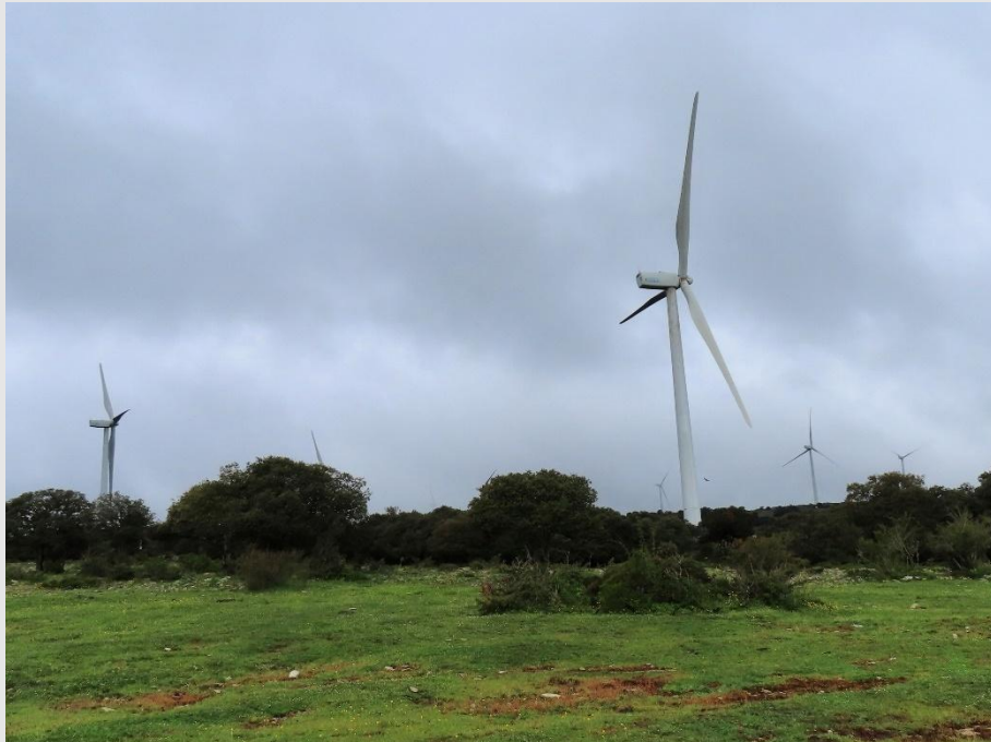
Fotografía 2. Vista general del parque eólico.
