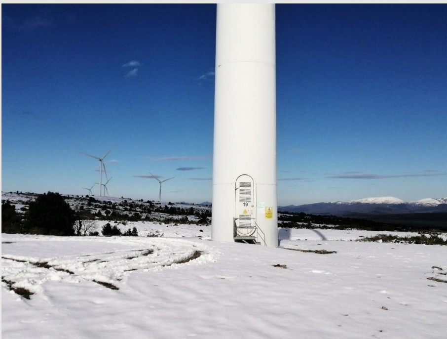
Fotografía 10. Vista general del parque eólico de Badaia en invierno con un enfoque en el aerogenerador 19.
