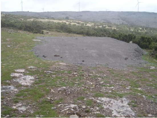
Plataforma aerogenerador nº9 antes del aporte de la tierra vegetal y la siembra.
