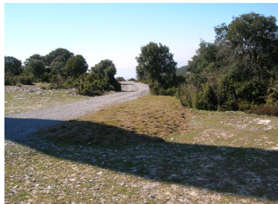
Plataforma aerogenerador nº26 tras el aporte de tierra vegetal.
