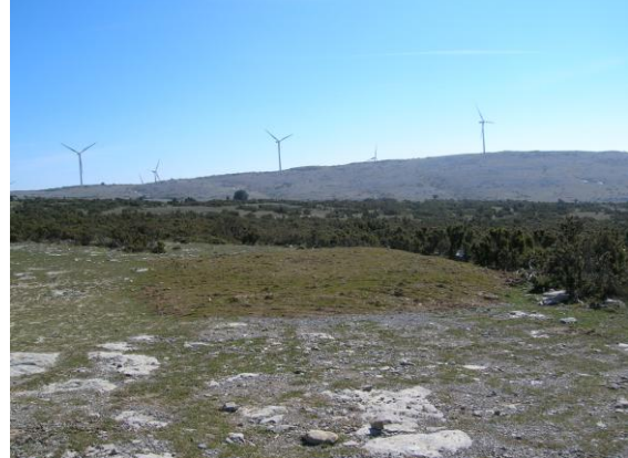
Plataforma aerogenerador nº9 tras el aporte de tierra vegetal.
