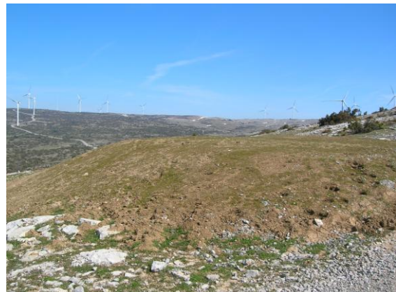
Plataforma aerogenerador nº914 tras el aporte de tierra vegetal.
