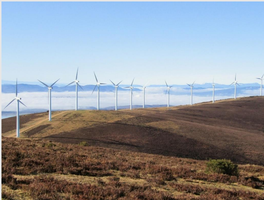
Fotografía 2. Vista general del parque eólico.
