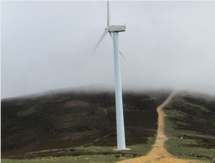
Fotografía 3. Detalle de uno de los viales del parque eólico.
