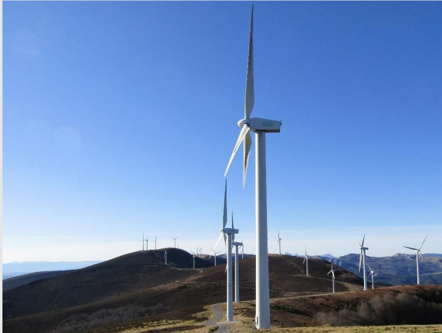
Fotografía 1. Vista general del parque eólico de Elgea-Urkilla.
