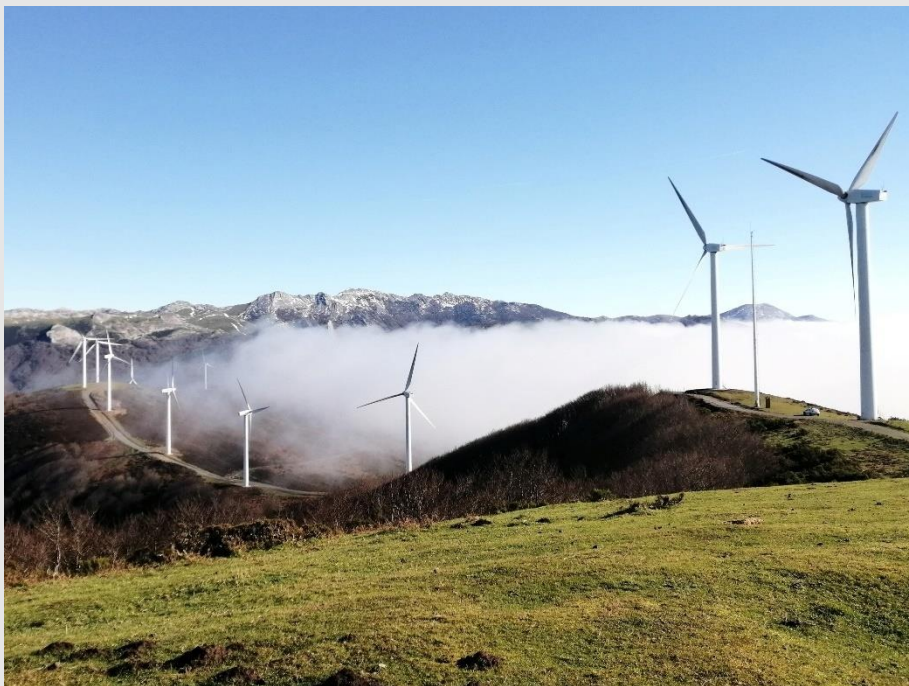
Fotografía 10. Vista general del parque eólico Elgea-Urkilla.
