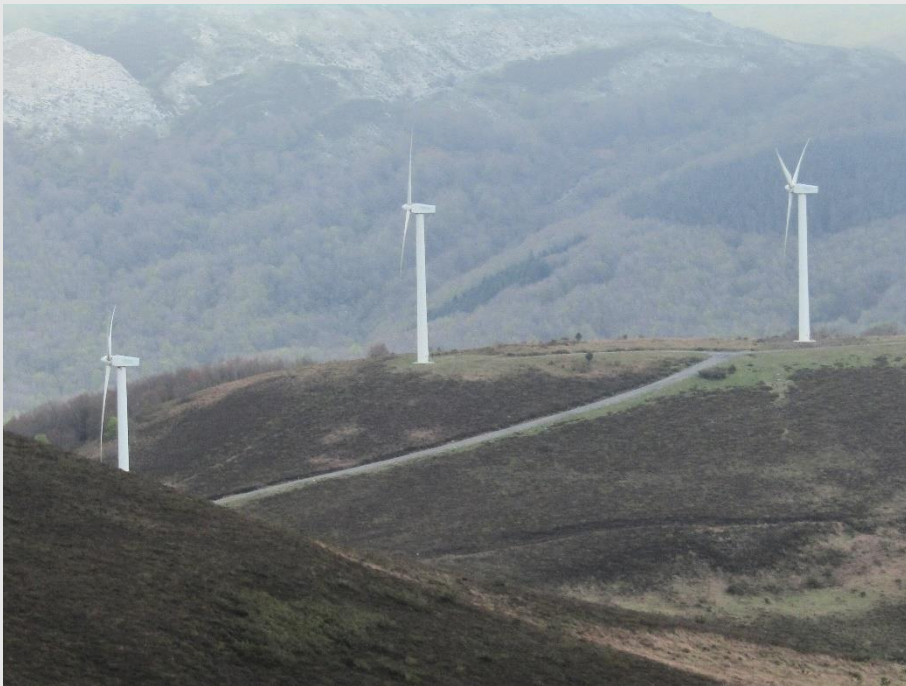
Fotografía 4. Vista general del parque eólico de Elgea-Urkilla
