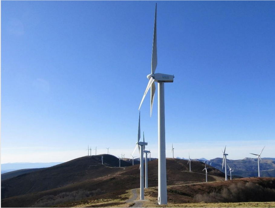
Fotografía 1. Vista general del parque eólico de Elgea-Urkilla.
