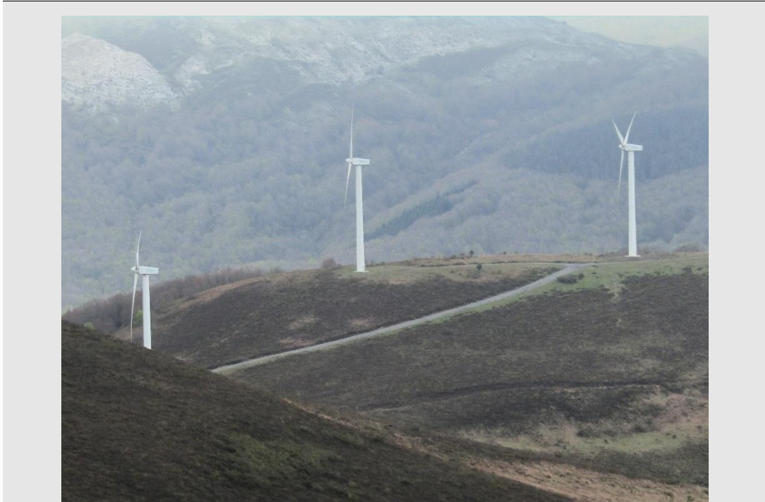
Fotografía 4. Vista general del parque eólico de Elgea-Urkilla
