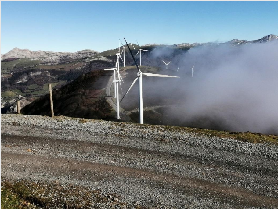
Fotografía 13. Detalle de vial de acceso al parque eólico.
