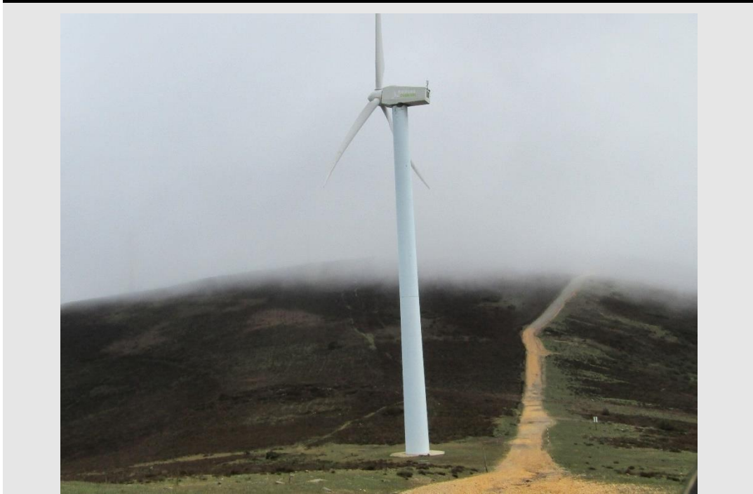
Fotografía 3. Detalle de uno de los viales del parque eólico.
