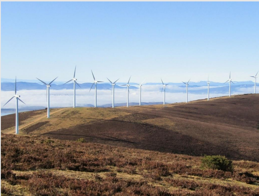
Fotografía 2. Vista general del parque eólico.
