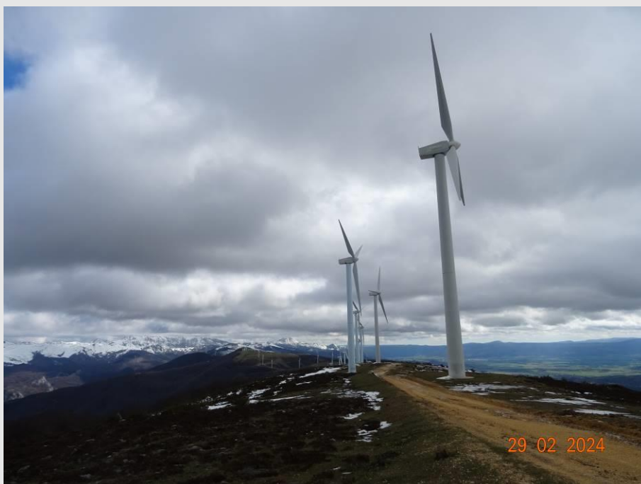
Fotografía 10. Vista general del parque eólico Elgea-Urkilla.
