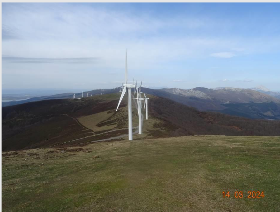
Fotografía 1. Vista general del parque eólico de Elgea-Urkilla.
