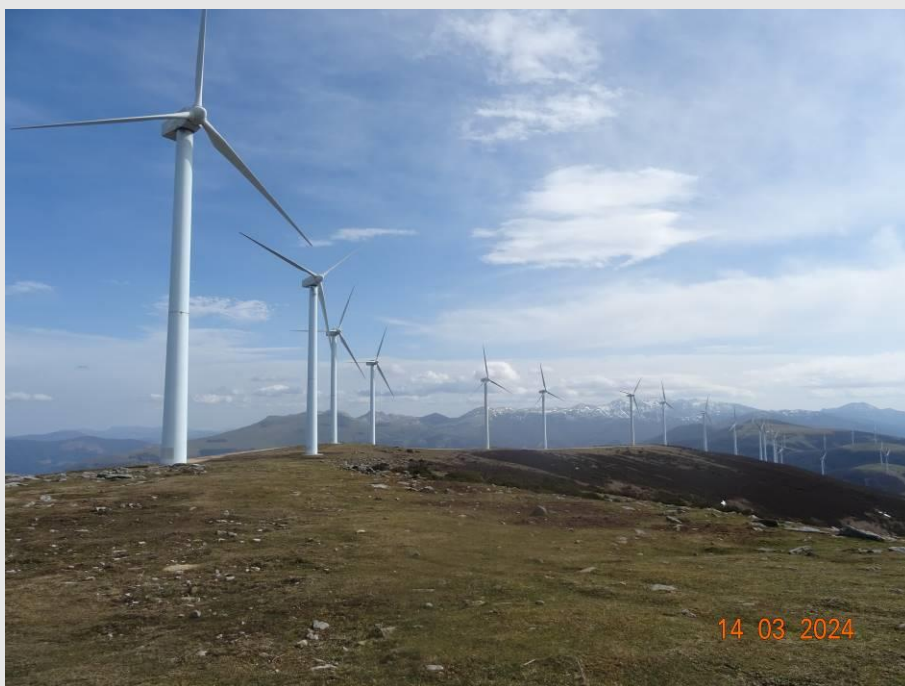
Fotografía 14. Vista general del parque eólico Elgea-Urkilla.
