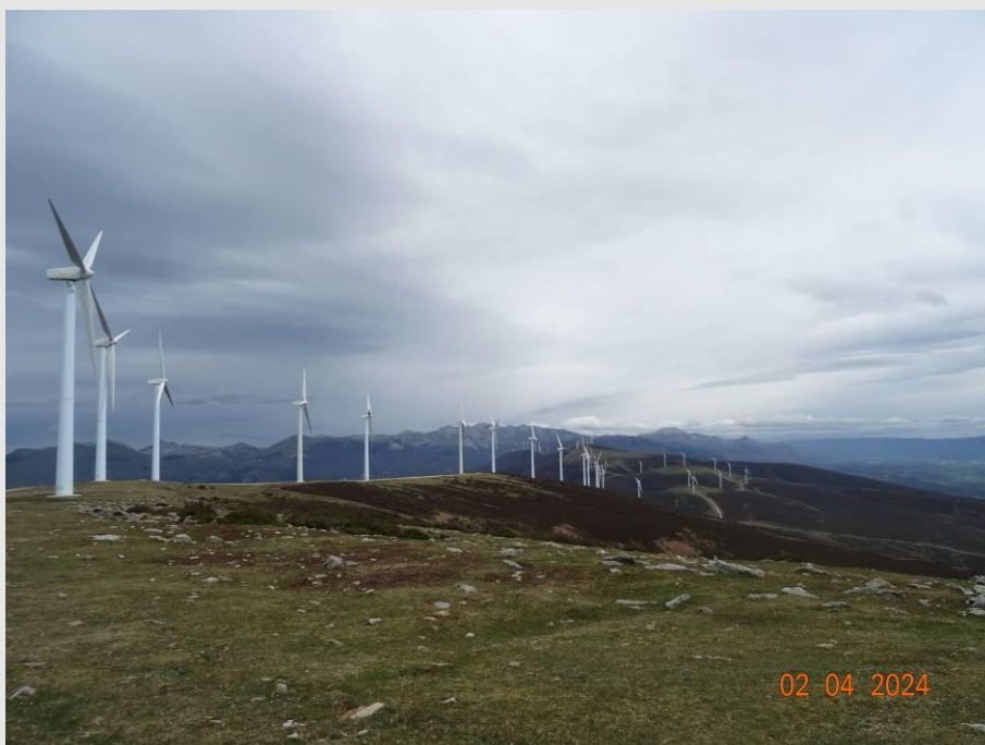
Fotografía 6. Vista general del parque eólico de Elgea-Urkilla.
