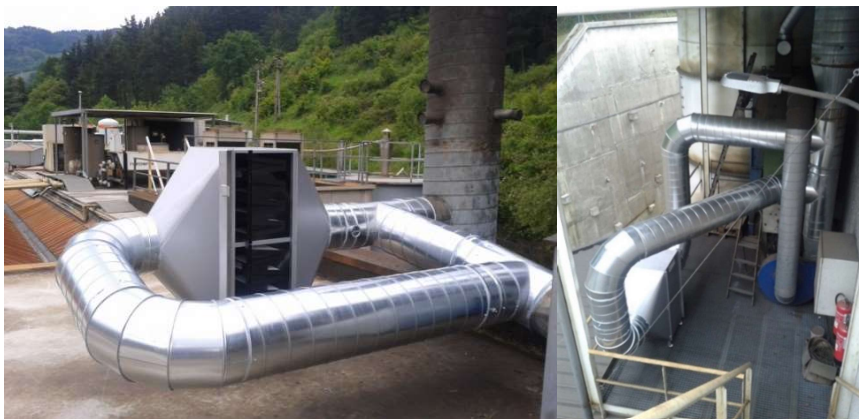
Figura 6.- Fotografías del filtro implementado en el foco de granallado
