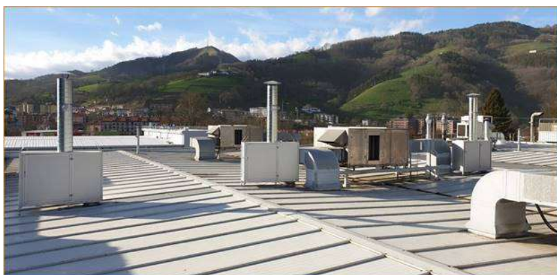
Figura 7.- Sistemas de depuración instalados en tres focos de Orkli, S.Coop.
