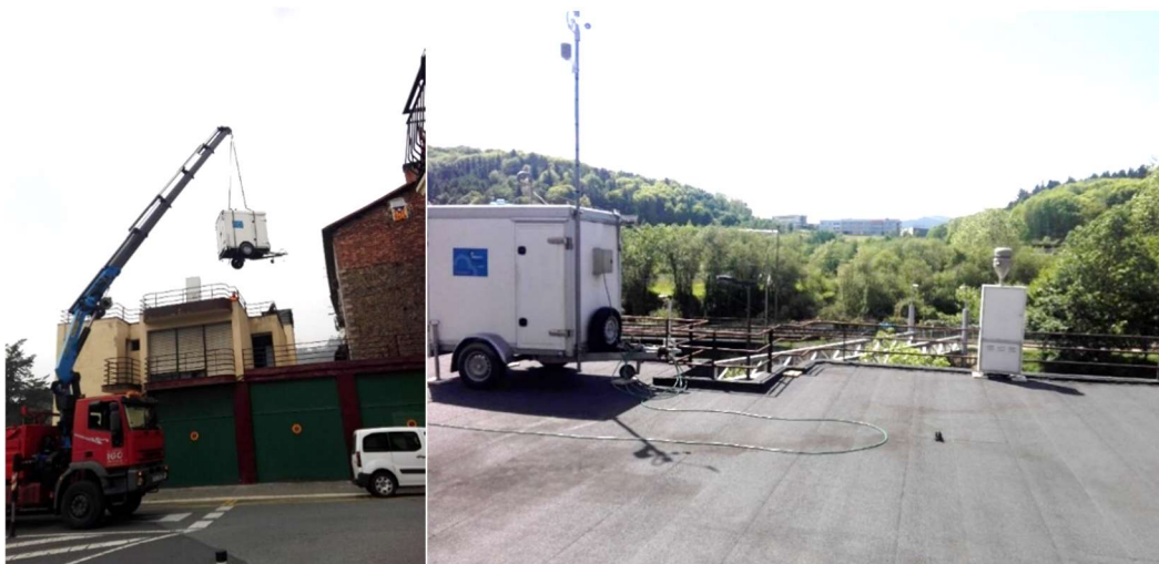
Figura 3.- Instalación del captador de partículas y la unidad móvil para meteorología ubicadas en el tejado del antiguo edificio de Bomberos de Ordizia.
