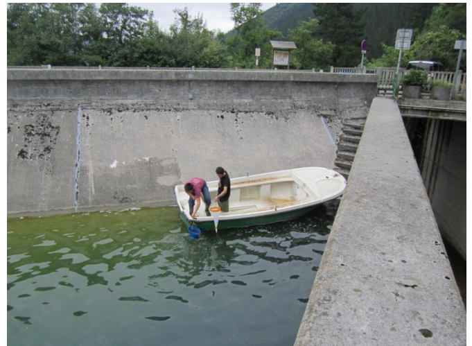
Figura 4. Imagen de muestreo mediante pozal en embalse con muro inclinado.
