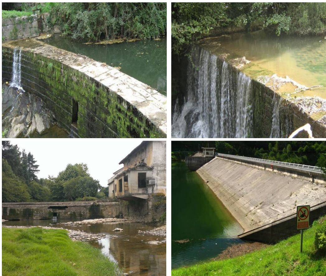
Figura 17. Fotografías de los tres azudes del río Arratia en los que se han ubicado las estaciones de muestreo IAR224, IAR223 e IAR 224 (de izquierda a derecha y de arriba abajo). Abajo izquierda presa del embalse de Undurraga junto a la que se encuentra la estación de muestreo UND-E.
