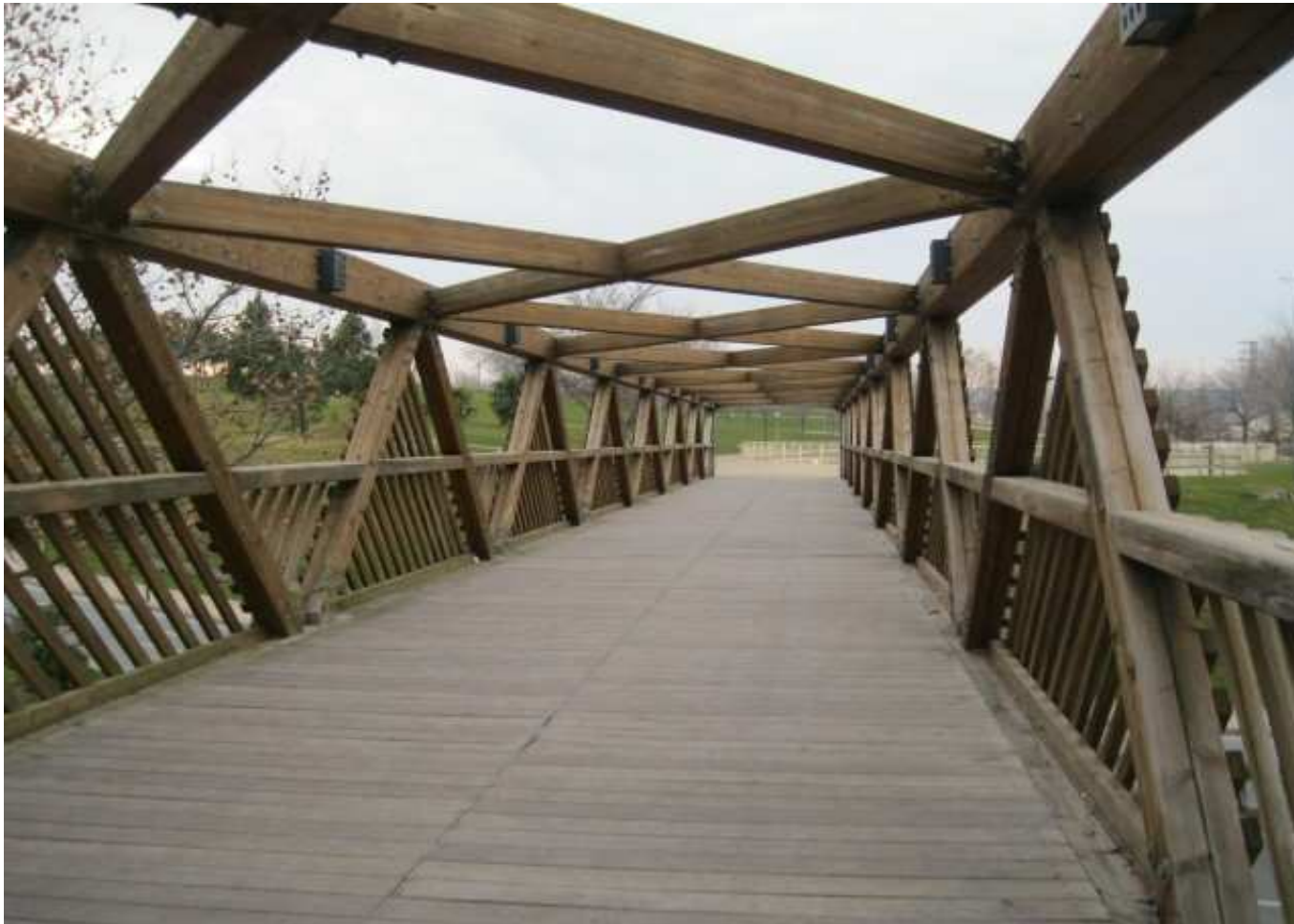
Vista de la tarima y de la estructura de madera de la pasarela
