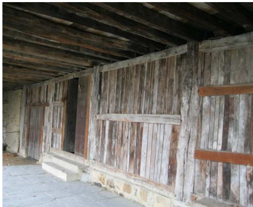
Detalles de la estructura de madera de roble del caserío de Ugartubeitia
