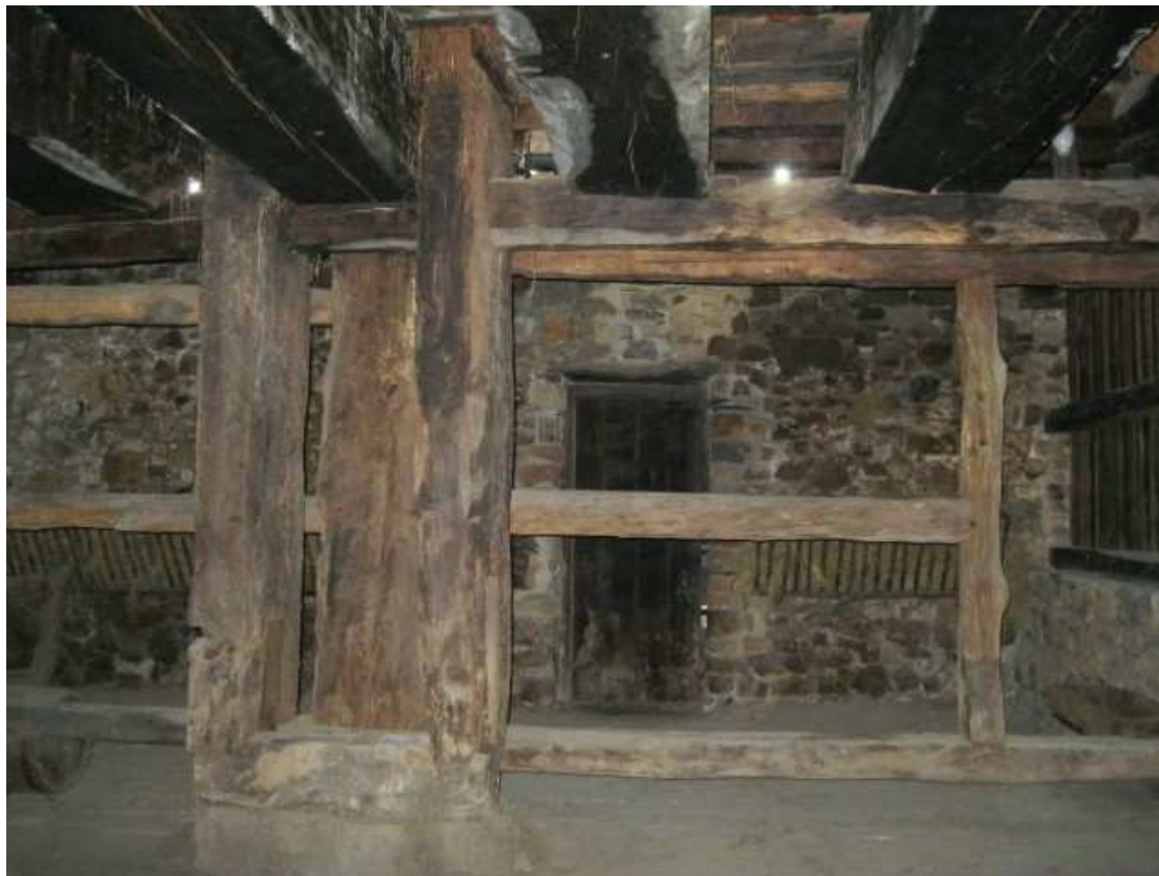
Estructura de madera de roble del caserío de Ugartubeitia
