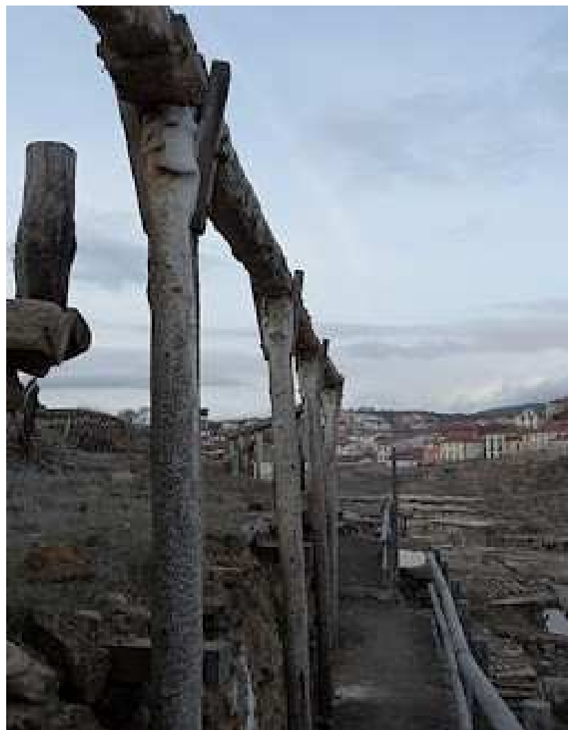
Canales de transporte de agua contruidos en madera
