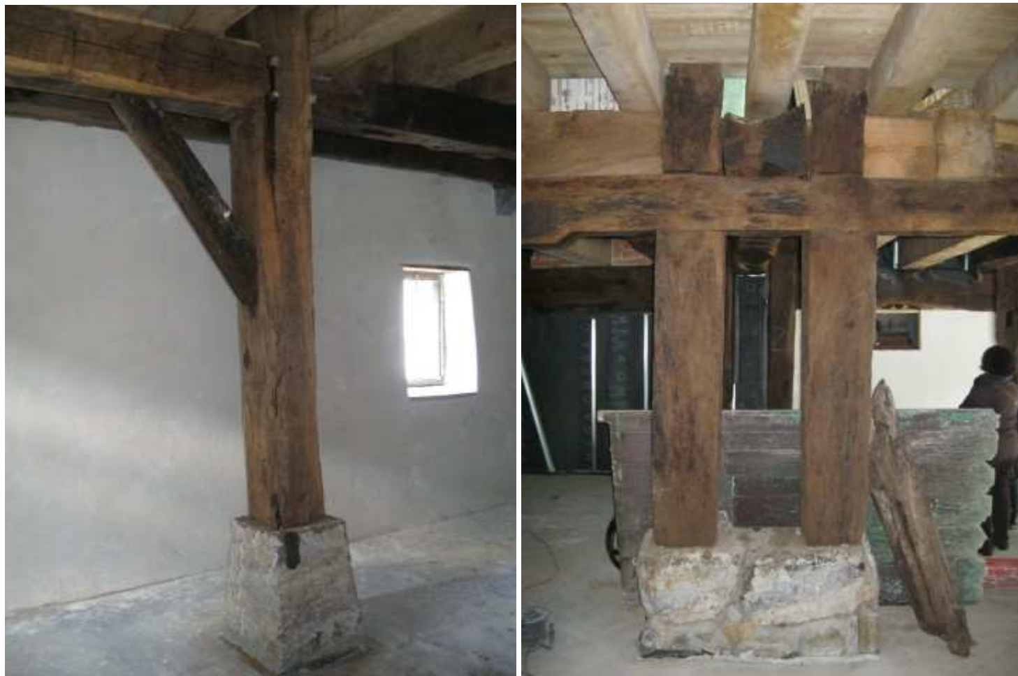
Detalles de la estructura de madera de roble del caserío de Ugarte
