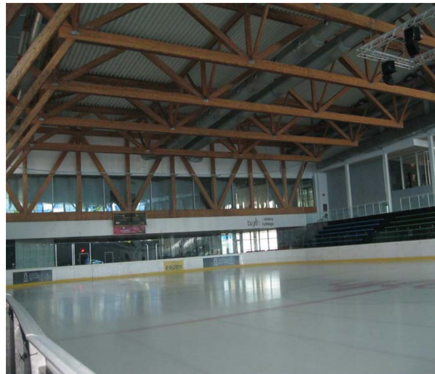
Vistas de la cubierta de madera de la pista de hielo de la ciudad del Baskonia
