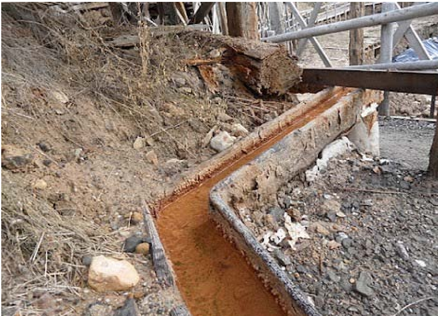
Detalle de canales de transporte de agua, formados por estructuras de mader
