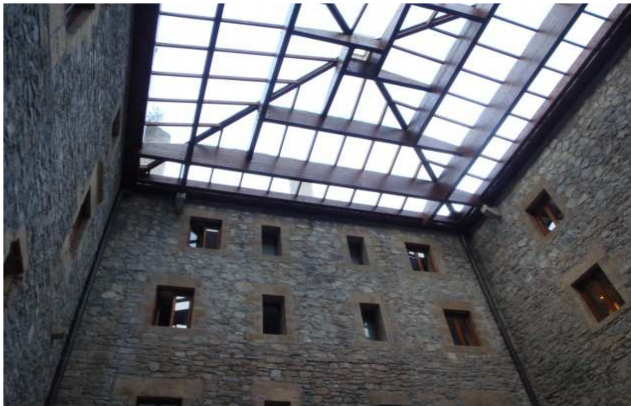
Cubierta de madera del patio central del parador de Fuenterrabía
