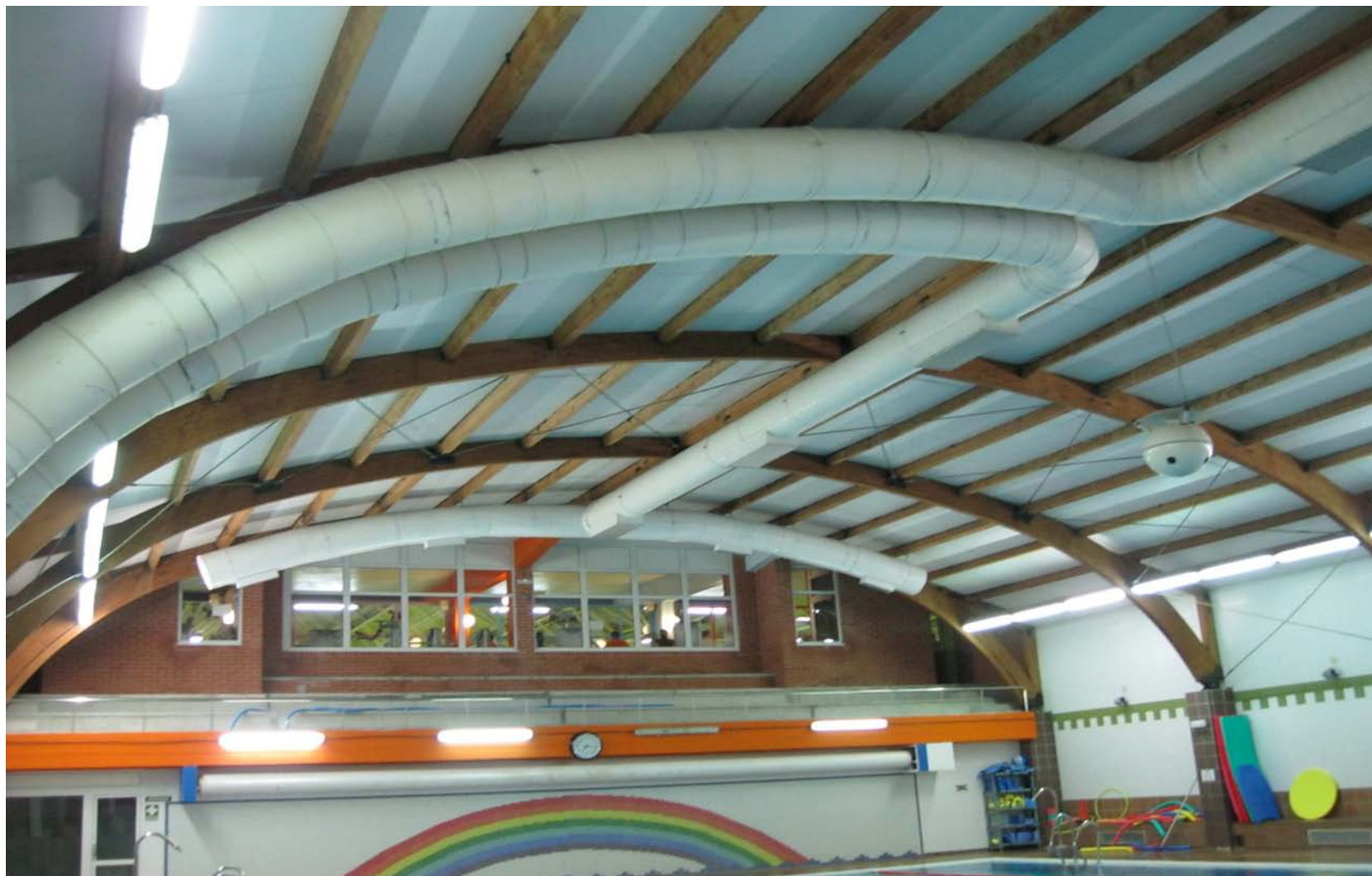
Cubierta de madera laminada de la piscina climatizada de Derio
