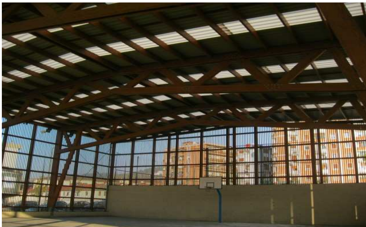
Vista del interior del polideportivo, con estructura y cerramiento de madera
