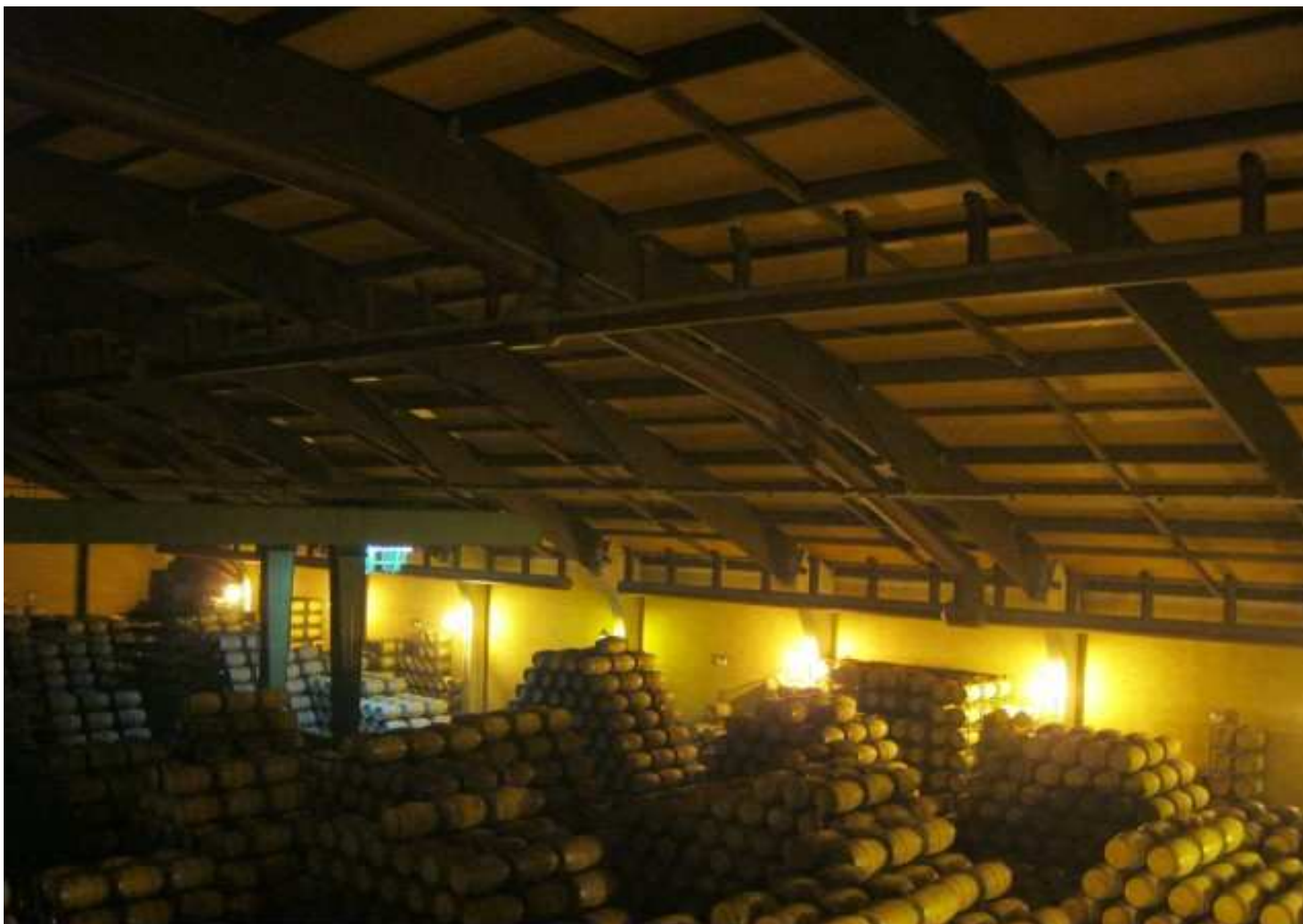
Vigas de madera de la cubierta de las bodegas
