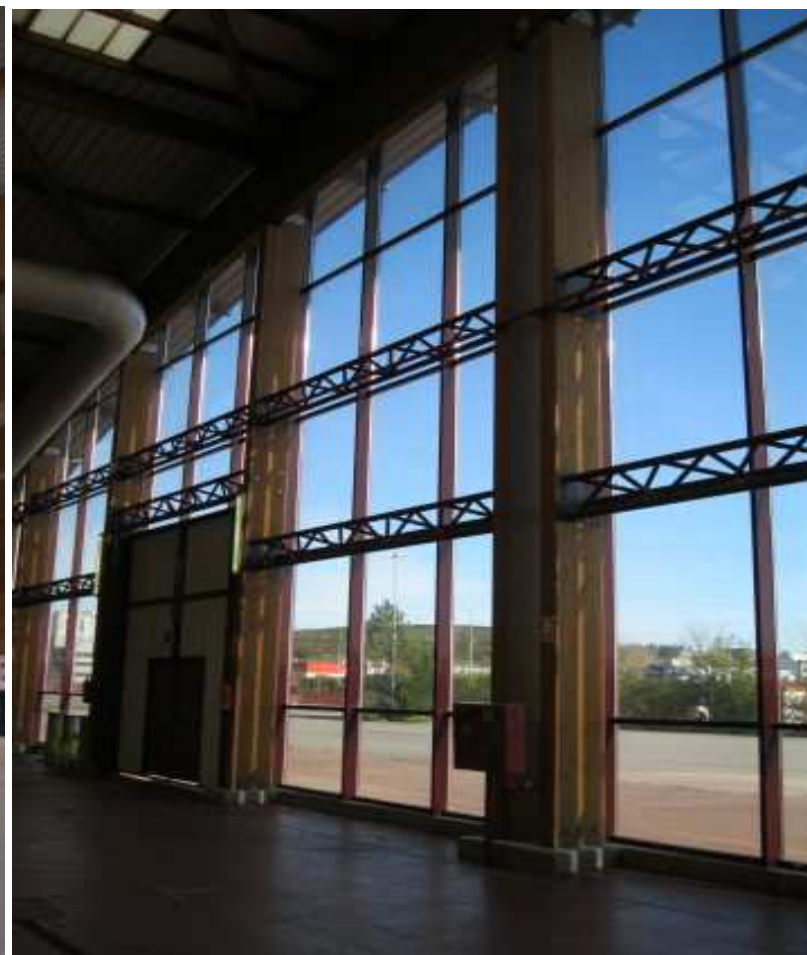
Detalles de la estructura de madera del mercado de Santiago de Compostela
