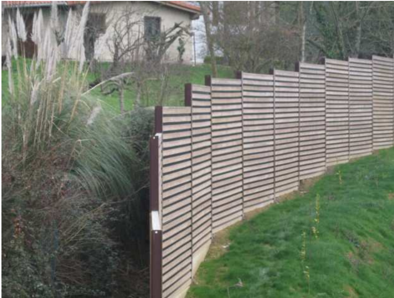
Detalle de las pantallas acústicas sobre la AP-8 a la altura de lurreta
