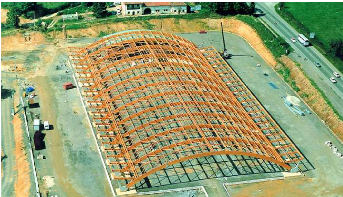
Vista aérea de la estructura de madera del mercado (Holtza)
