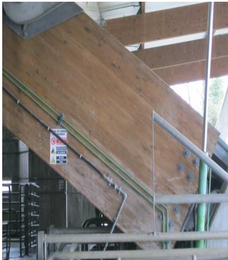
Detalle de la estructura de madera laminada del mercado
