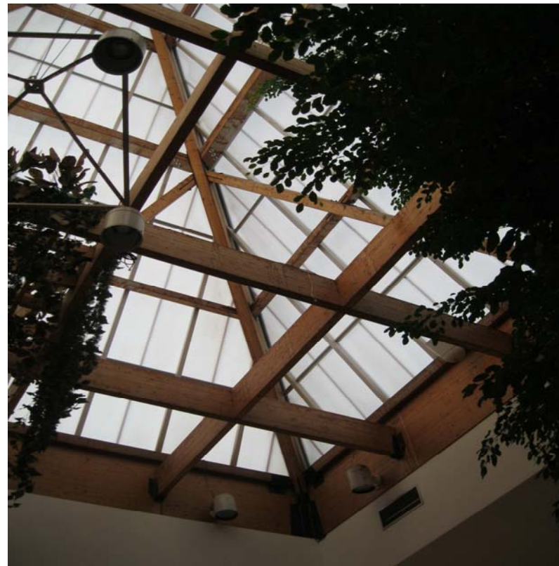
Detalle de la cúpula de madera acristalada
