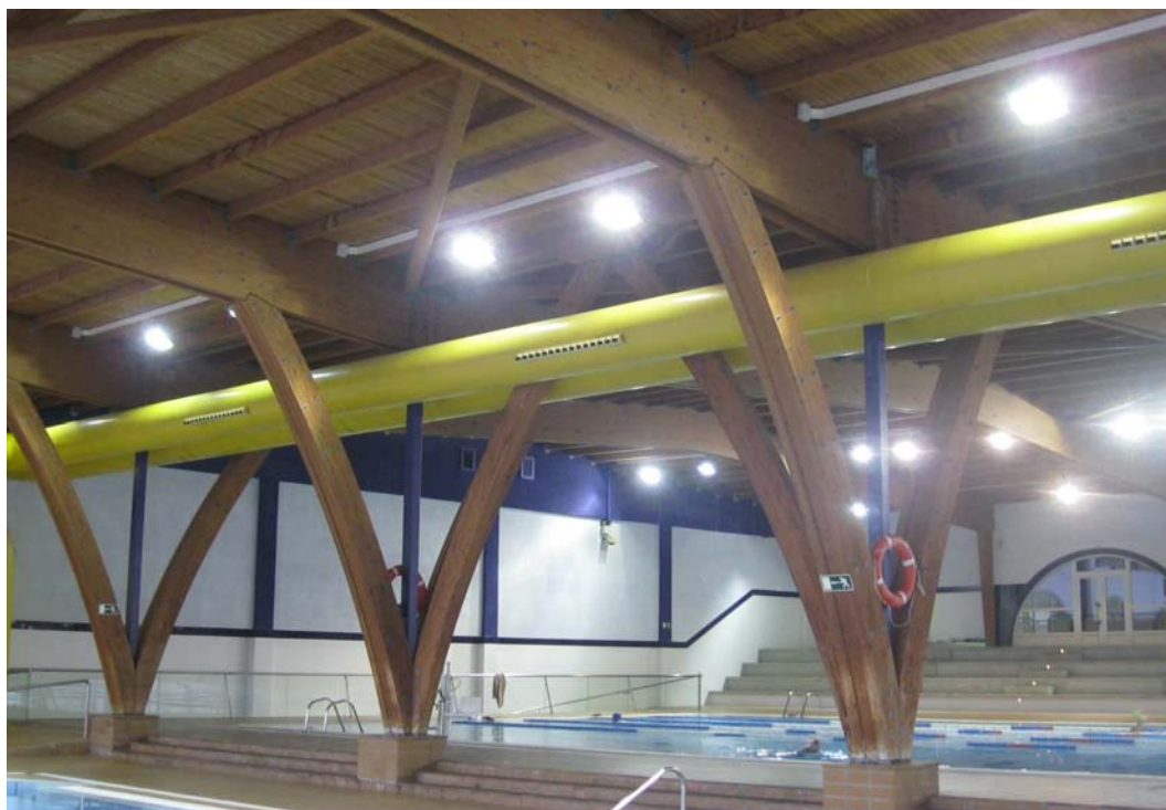
Vista general de la cubierta y pilares de madera laminada
