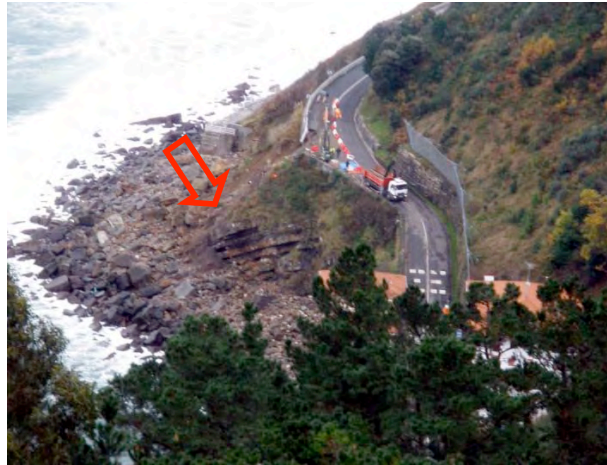
Foto 1: Ladera desarrollada sobre las areniscas y lutitas del Complejo Supraurgoniano formando un anticlinal paralelo a la costa. La ladera coincide con el flanco NE que buza fuertemente hacia el mar.
