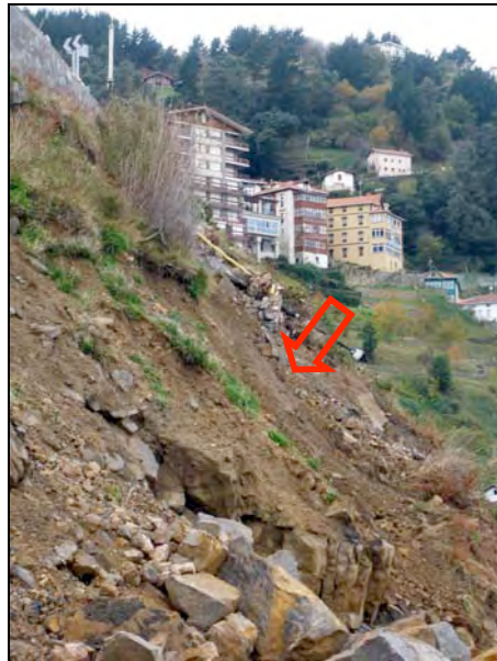
Foto 3: Detalle de los desprendimientos
