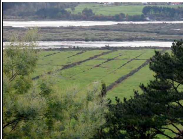
Foto 3: Detalle de los canales y muros.
