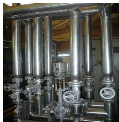
Foto1.- Antes de la aplicación de la medida
