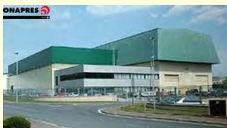
Instalaciones de ONAPRES
