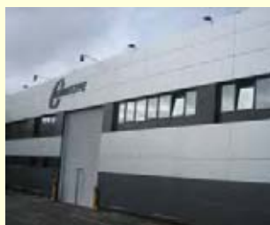
Instalaciones de TORNOS GURUTZPE
