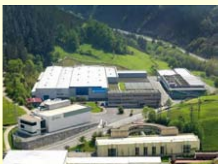
Instalaciones de DANOBAT
