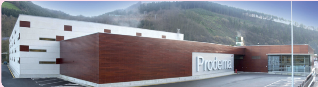
◀ Prodema, S.A. enpresaren instalazioak, Legorretan (Gipuzkoa). Iturria: Prodema S.A.
